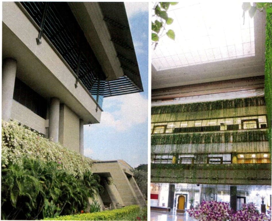
ภาพ 4-25 (ซ้าย) ผู้ออกแบบอาคารธนาคารแห่งประเทศไทย สำนักงานภาคเหนือ ได้คำนึงถึงการประหยัดพลังงาน จึงออกแบบให้นั่งอาคารเอียง และชายคายื่นยาว เพื่อบังแดด (ขวา) การนำแสงธรรมชาติเข้าสู่ภายในส่วนโถงกลางของอาคาร ถือเป็นอีกแนวทางหนึ่งในการประหยัดพลังงาน (ที่มา: ผู้วิจัย, ธันวาคม 2554)
