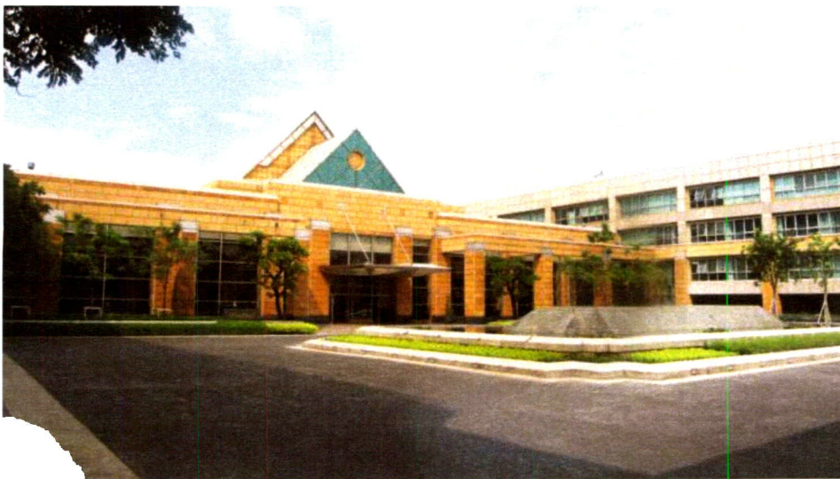
ภาพ 4-17 บริเวณด้านหน้า อาคารกระทรวงการต่างประเทศ (ที่มา: ผู้วิจัย, มีนาคม 2555)
