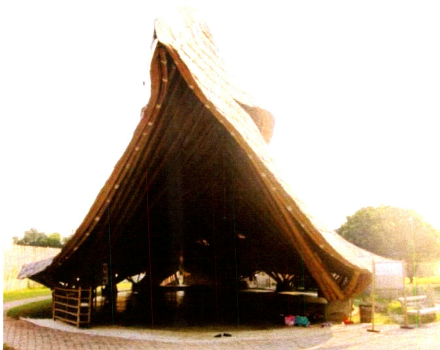
ภาพ 2-4 อาคารเรียนโรงเรียนปัญญาเด่น ลักษณะหลังคาทรงสูง และเจาะช่องเปิดไว้บนหลังคา ประกอบกับการไม่มีผนังโอบล้อมตัวอาคาร ส่งผลให้ภายในอาคารเย็น เนื่องจากอากาศถ่ายเทได้ดีจากการระบายอากาศโดยวิธีธรรมชาติ (ที่มา: ผู้วิจัย, ธันวาคม 2554)
