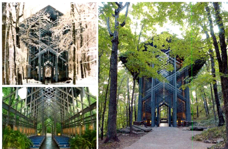
ภาพ 2-17 โบสถ์ Thorncrown ตั้งอยู่ท่ามกลางธรรมชาติ ใช้เหล็กเป็นโครงสร้างหลักเพื่อความโปร่งโล่ง และใช้กระจกเป็นส่วนหนึ่งของผนังเพื่อให้พื้นที่ภายนอกและภายในสามารถเชื่อมโยงถึงกัน (ที่มา: Christopher, 2013)
