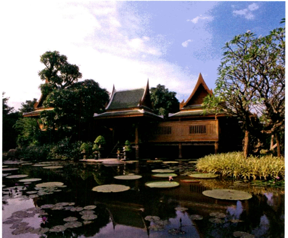
ภาพ 2-3 เรือนไทยหมู่ เสถียรธรรมสถาน ออกแบบโดยภิญโญ สุวรรณคีรี รูปแบบของเรือนไทยที่ใต้ถุนเป็นบ่อน้ำ ซึ่งเมื่อลมพาละอองน้ำพัดผ่านบริเวณอาคาร จะทำให้เกิดการแลกเปลี่ยนอุณหภูมิ (ที่มา: ภิญโญ สุวรรณคีรี, 2 มิถุนายน 2556)
