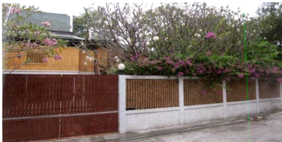
ภาพ 2-2 รั้วบ้านของภิญโญ สุวรรณศิริ เป็นกำแพงที่ก่อด้วยอิฐมอญที่มีรูปแบบเว้นช่องสลับพื้นปลา รั้วบ้านจึงไม่ทึบ มีการระบายอากาศโดยวิธีธรรมชาติ มีส่วนช่วยลดปรากฏการณ์สะสมความร้อน (ที่มา: ผู้วิจัย, ธันวาคม 2554)
