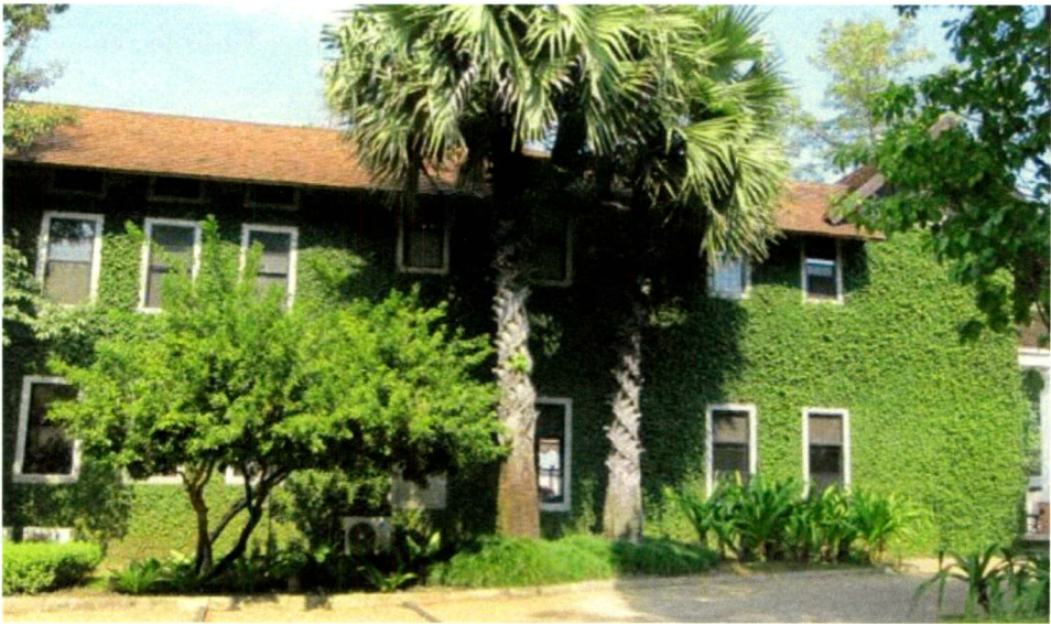
ภาพ 2-9 โรงแรมราชมรรคา มีการจัดทำพื้นที่สีเขียวในแนวตั้ง โดยการปลูกต้นไม้ดินปลูกแก้วไว้บนผนังด้านทิศตะวันตก เพื่อให้ร่มเงากับผนังอาคารในช่วงบ่าย และให้ความสวยงามแก่สถานที่ (ที่มา: ผู้วิจัย, ธันวาคม 2554)
