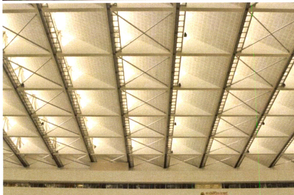
ภาพ 2-6 ศูนย์ราชการเฉลิมพระเกียรติ มีการเจาะช่องแสงขนาดใหญ่ โดยออกแบบให้ช่องเปิดเฉียงรับเฉพาะแสงทางด้านทิศเหนือ ทำให้ในบริเวณโถงกลางของอาคารได้รับแสงสว่างธรรมชาติ แต่ไม่ได้รับความร้อนจากภายนอก (ที่มา: ผู้วิจัย, มีนาคม 2555)
