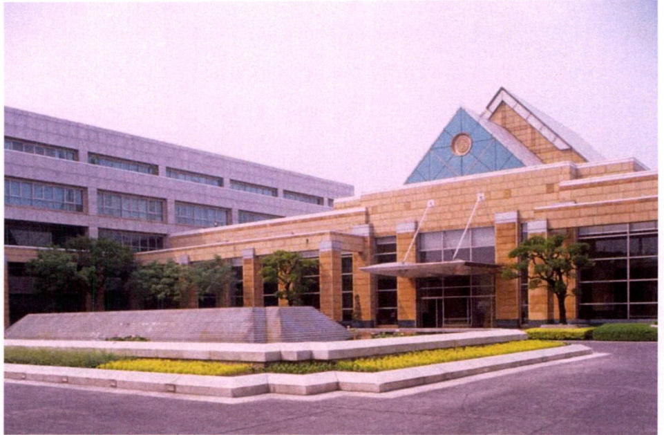
ภาพ 4-7 อาคารกระทรวงการ ต่างประเทศ (ที่มา: ผู้วิจัย, มีนาคม 2555)
