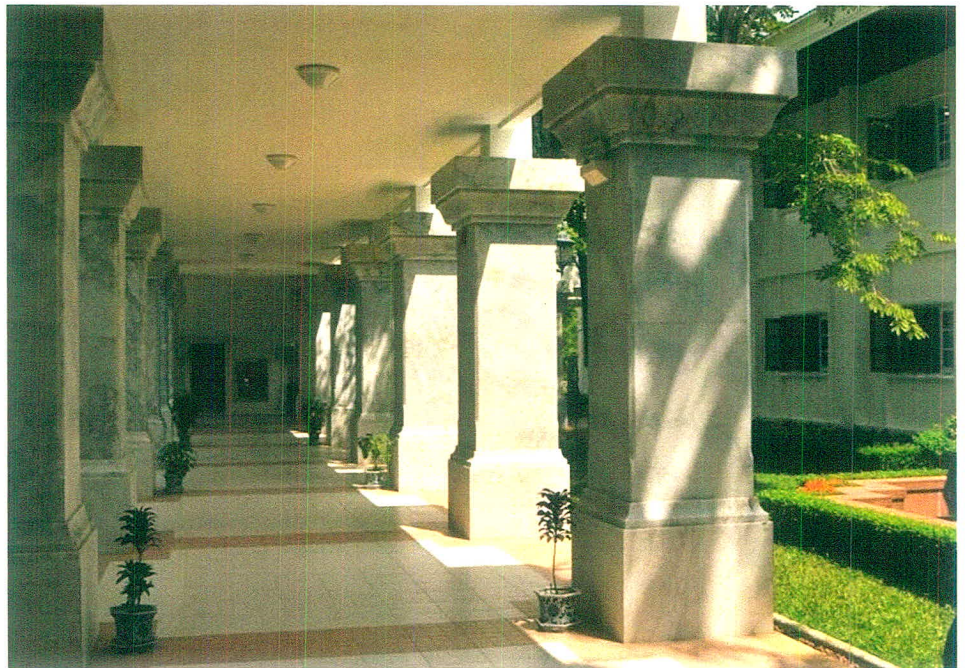
ภาพ 2-21 บริเวณใต้ถุนอาคาร พระราชวังปากพ่อง จังหวัดนครศรีธรรมราช สถาปนิก: วิทยุ สุวรรณคีรี (ที่มา: ผู้วิจัย, พฤษภาคม 2555)
