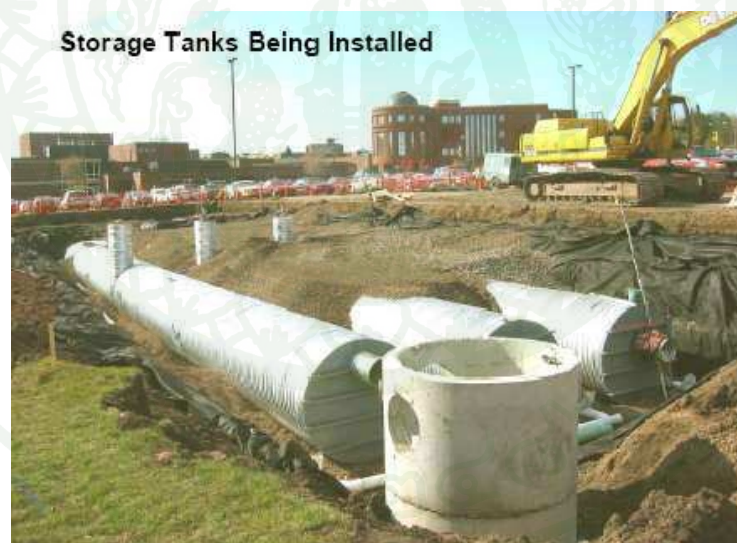
ภาพที่ 13 การก่อสร้างแหล่งเก็บน้ำใต้ดิน อันเป็นผลมาจากการเกิดพายุฝนในเขตเมือง
