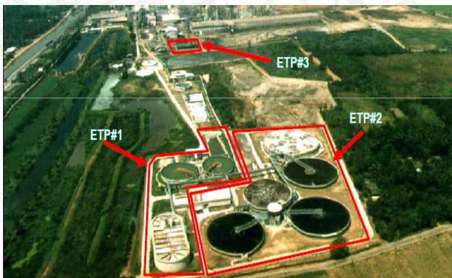
ภาพที่ 10 Effluent Treatment Plant ของอุตสาหกรรมการผลิตเยื่อและกระดาษ โรงงานบ้านโป่ง
