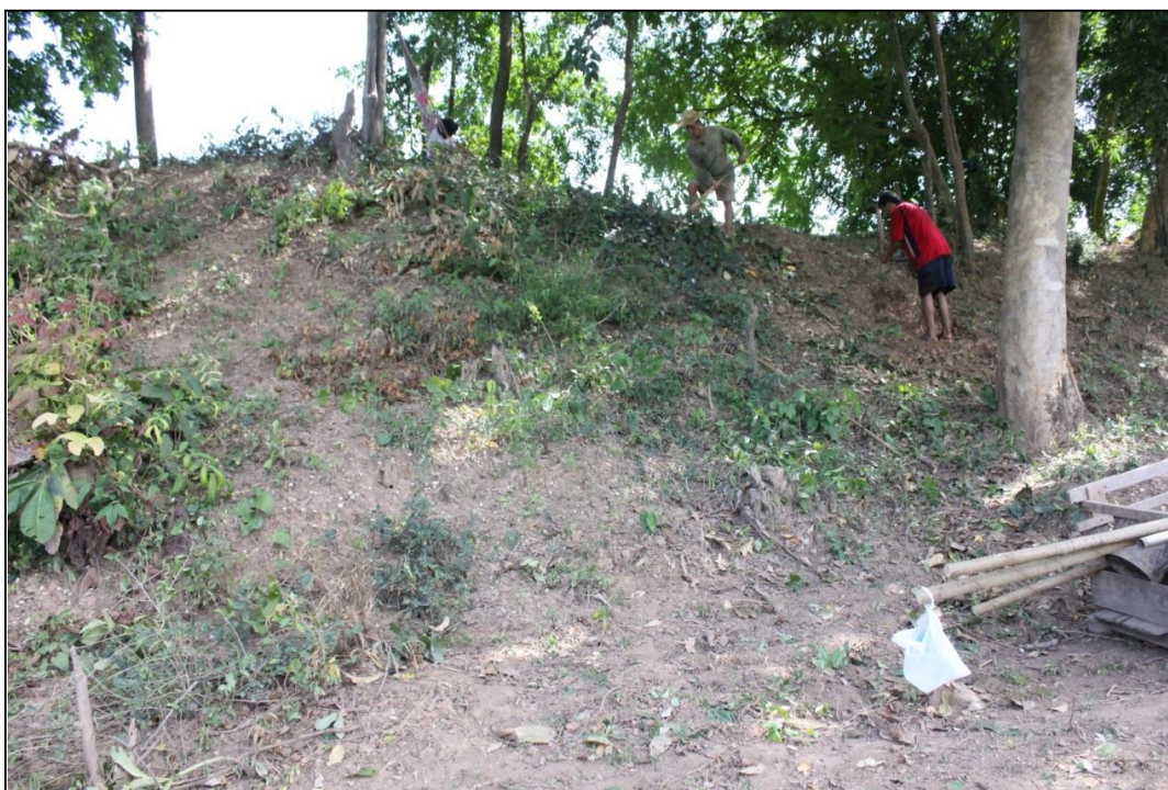
ภาพที่ 48 สภาพทั่วไปของกำแพงเมืองพิชัยขณะทำการปรับสภาพพื้นผิวก่อนการขุดตรวจ
