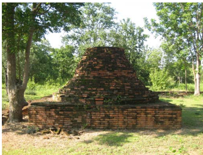
ภาพที่ ๑๒๕ เจดีย์รายทรงปรางค์ ในวัดแม่หม้ายใต้หลังการบูรณะ
