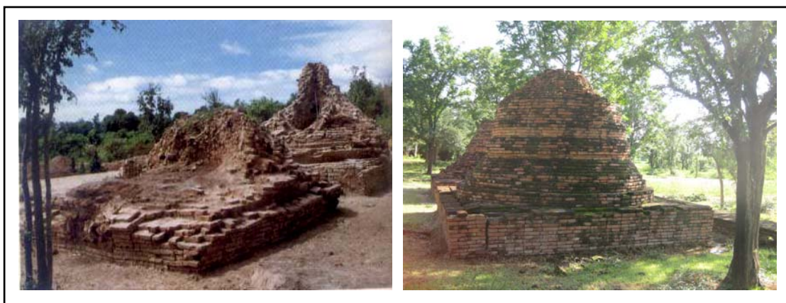
ภาพที่ ๓๓ เจดีย์ทรงกลมหมายเลข ๑ ในวัดแม่หม้ายใต้ที่พบจากการขุดแต่งและหลังการบูรณะ
