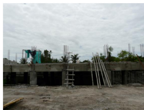
ทางเชื่อมของคานฟ้า อาคารเอนกประสงค์เดิมและอาคารศาลาการเปรียญหลังใหม่
