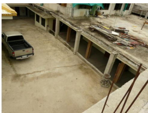
บริเวณลาดจอดรถเดิม ที่มีการตัดต้นไม้เก่าถมดินทำลานจอดรถใหม่
