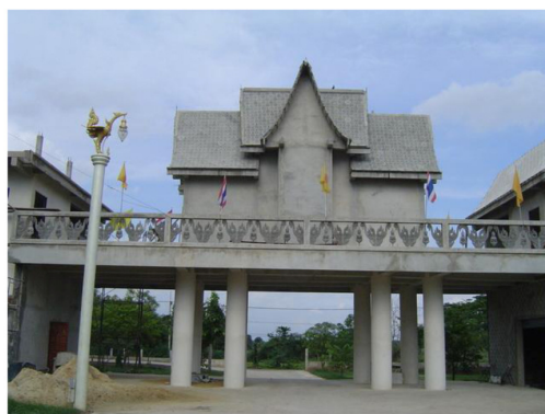
ซุ้มประตูทางเข้าวัด ยังสร้างไม่แล้วเสร็จ
