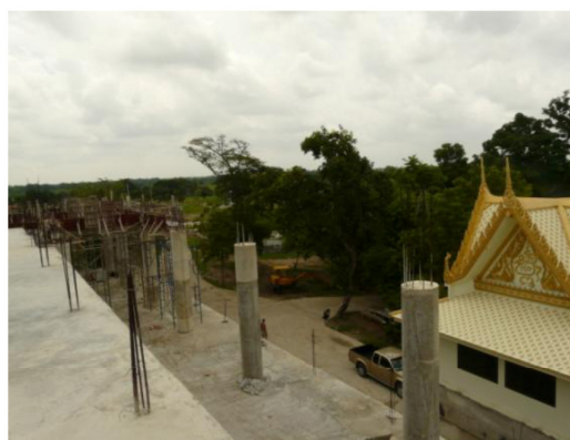
อาคารศาลาการเปรียญ 3 ชั้นที่อยู่ระหว่างการ ก่อสร้าง
