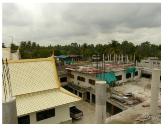
ชั้นบนของอาคารเอนกประสงค์เดิม มี ก่อสร้างเพิ่มเติม แต่ยังคงเก็บส่วนวิหารไว้
