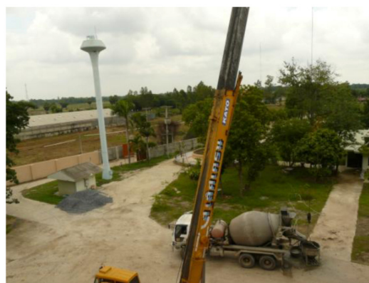
ภาพการทำงานในระหว่างการก่อสร้างศาลา การเปรียญ
