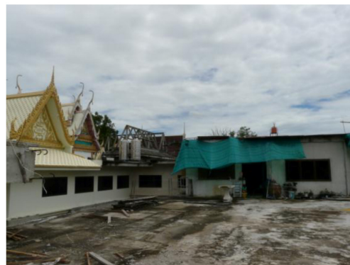
ชั้นบนของอาคารเอนกประสงค์หลังเก่า
