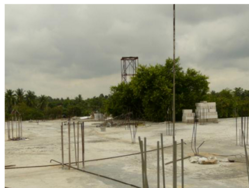
บนคาบฟ้าศาลาการเปรียญ ที่มีการโผล่เหล็ก ไว้ ต่อเติมในอนาคต
