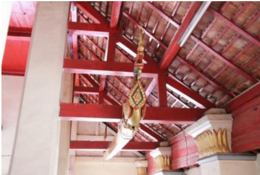
ภาพที่ 34 รูปแสดงโครงหลังคาที่เป็นรูปแบบคล้ายสุโขทัย
