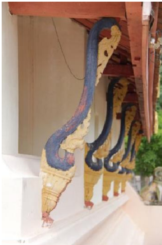
ภาพที่ 35 รูปแสดงคันทวยพญานาค เป็นของเดิมยังใช้งานได้
