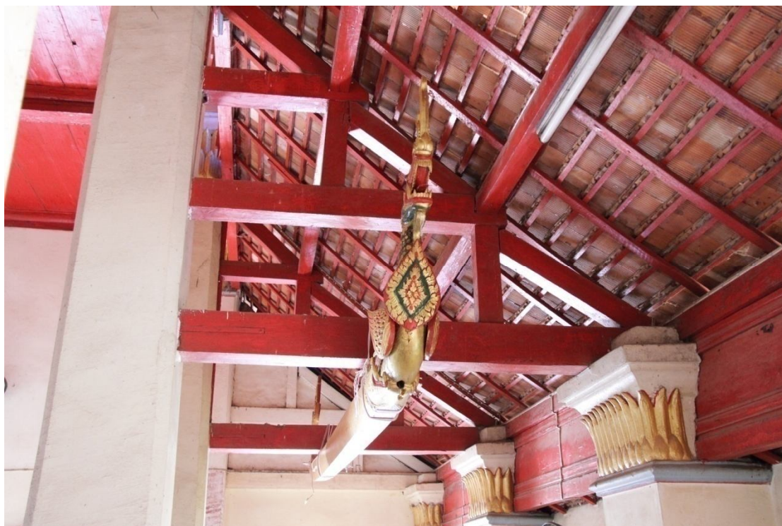
ภาพที่ 67 รูปแสดงโครงสร้างไม้ระบบช้อยตูกตาแบบมีจันทัน
