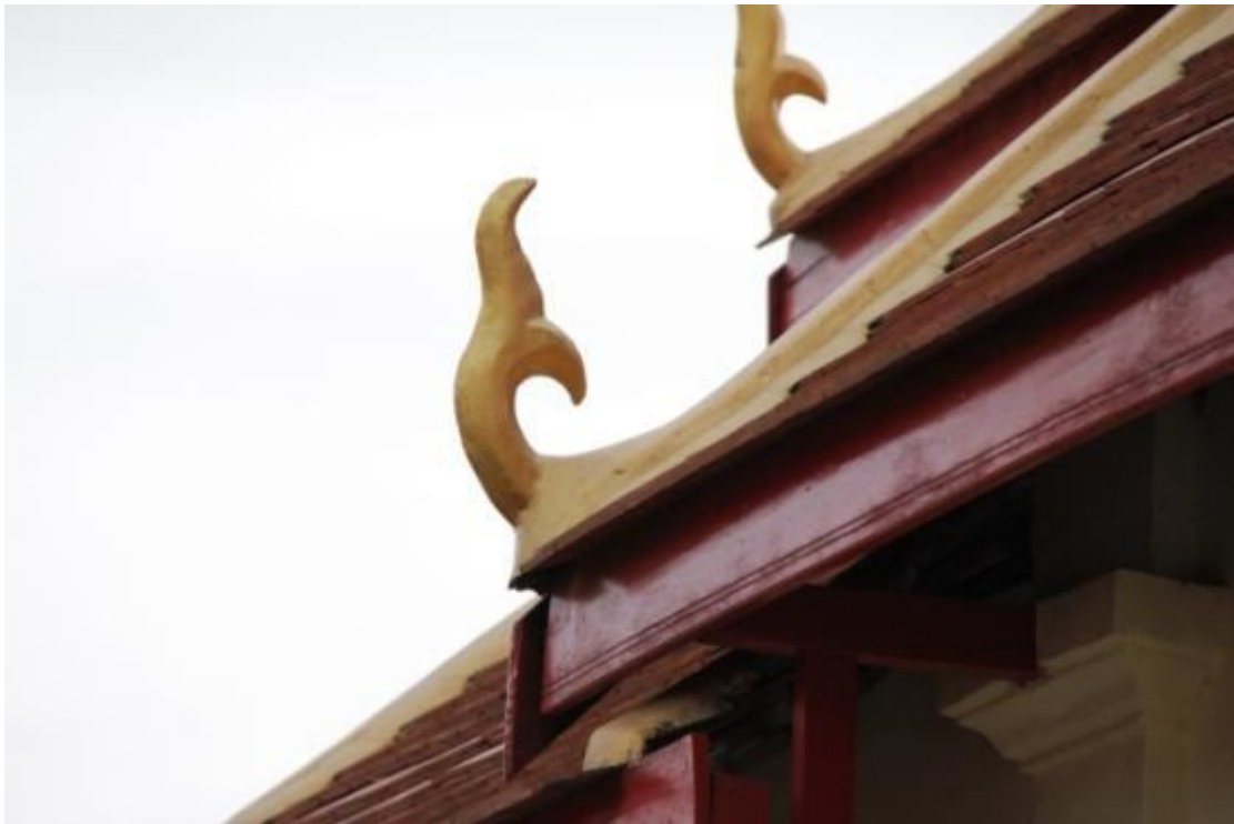
ภาพที่ 41 รูปแสดงหางหงส์และโครงสร้างหลังคาบางส่วนวัดช้างเผือก อ.ศรีเชียงใหม่ จ.หนองคาย
