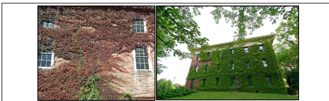
ภาพที่ 4 การใช้ Green Wall แบบ direct growth
