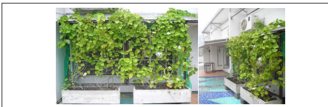
ภาพที่ 11 แผงกันแดดไม้เลื้อยสร้อยอินทนิลที่ปลูก ณ ทิศตะวันตกของอาคาร
