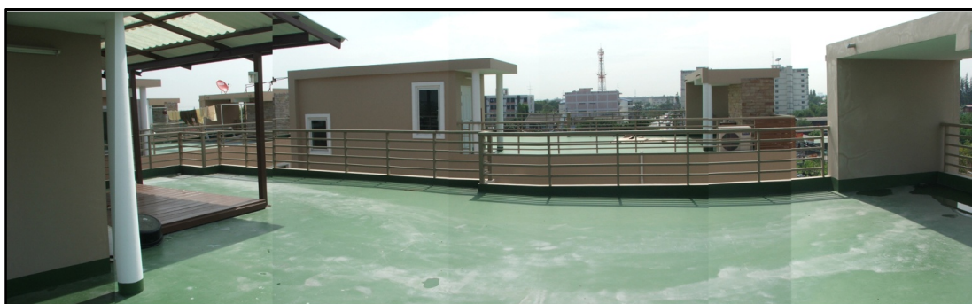
ภาพที่ 30 แสดงบริเวณพื้นดาดฟ้าของอาคารที่ใช้ในการทดลอง
