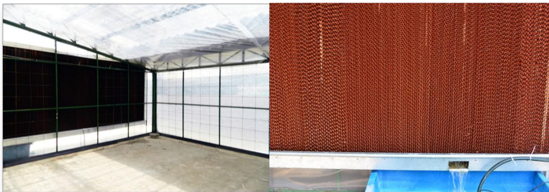
รูปที่ 14 การติดตั้งแผ่น cooling pad ที่ผนังห้องเลี้ยงเนื้อเยื่อที่ปรับปรุงจากเรือนเพาะชำ (ซ้าย) พร้อมวางระบบน้ำลงถึงก่อนปั้มน้ำกลับไปใช้ใหม่ (ขวา)
