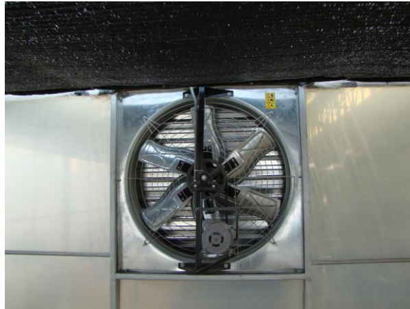
รูปที่ 15 การติดตั้งพัดลมขนาด 36 นิ้ว ที่ผนังห้องเลี้ยงเนื้อเยื่อที่ปรับปรุงจากเรือนเพาะชำเพื่อระบายความร้อน
