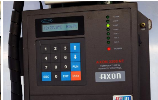
รูปที่ 16 ตู้ควบคุม Axon 2200 NT ที่ติดตั้งด้านนอกห้องเลี้ยงเนื้อเยื่อสำหรับควบคุมอุณหภูมิและความชื้น โดยมีเซ็นเซอร์สำหรับตรวจวัดอุณหภูมิและความชื้นในห้องเลี้ยงเนื้อเยื่อ
