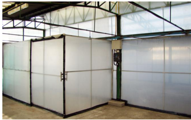
รูปที่ 13 ประตูทางเข้าห้องเลี้ยงเนื้อเยื่อที่ปรับปรุงจากเรือนเพาะชำให้มีประตู 2 ชั้น
