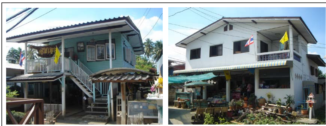
ภาพที่ 27 แสดงลักษณะอาคารพักอาศัยภายในเกาะเกร็ด
