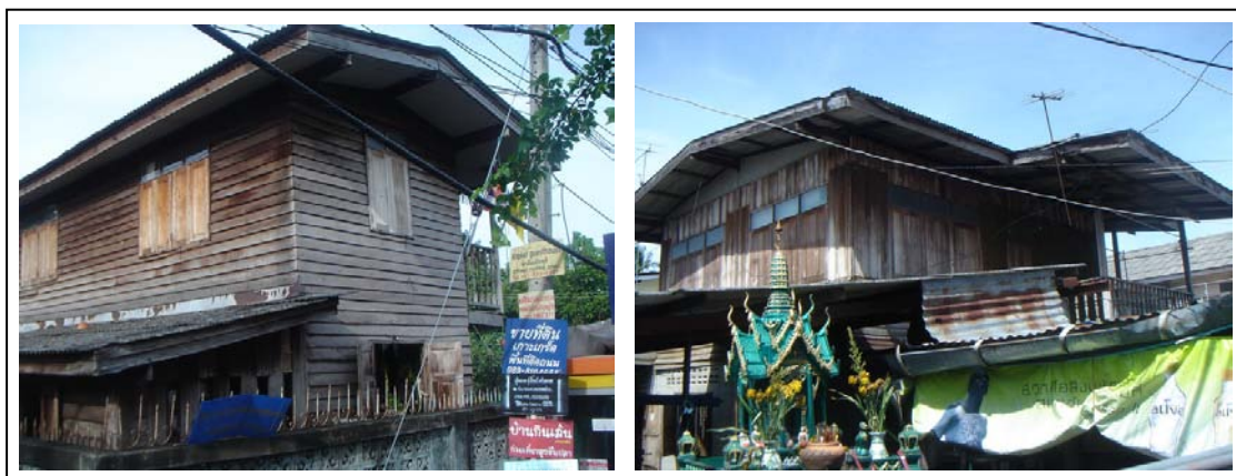
ภาพที่ 26 แสดงลักษณะอาคารพักอาศัยภายในเกาะเกร็ด
