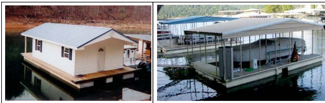
ภาพที่ 77 แสดงการใช้งาน EPS FOAM กับงานจริงที่สามารถลอยน้ำได้
