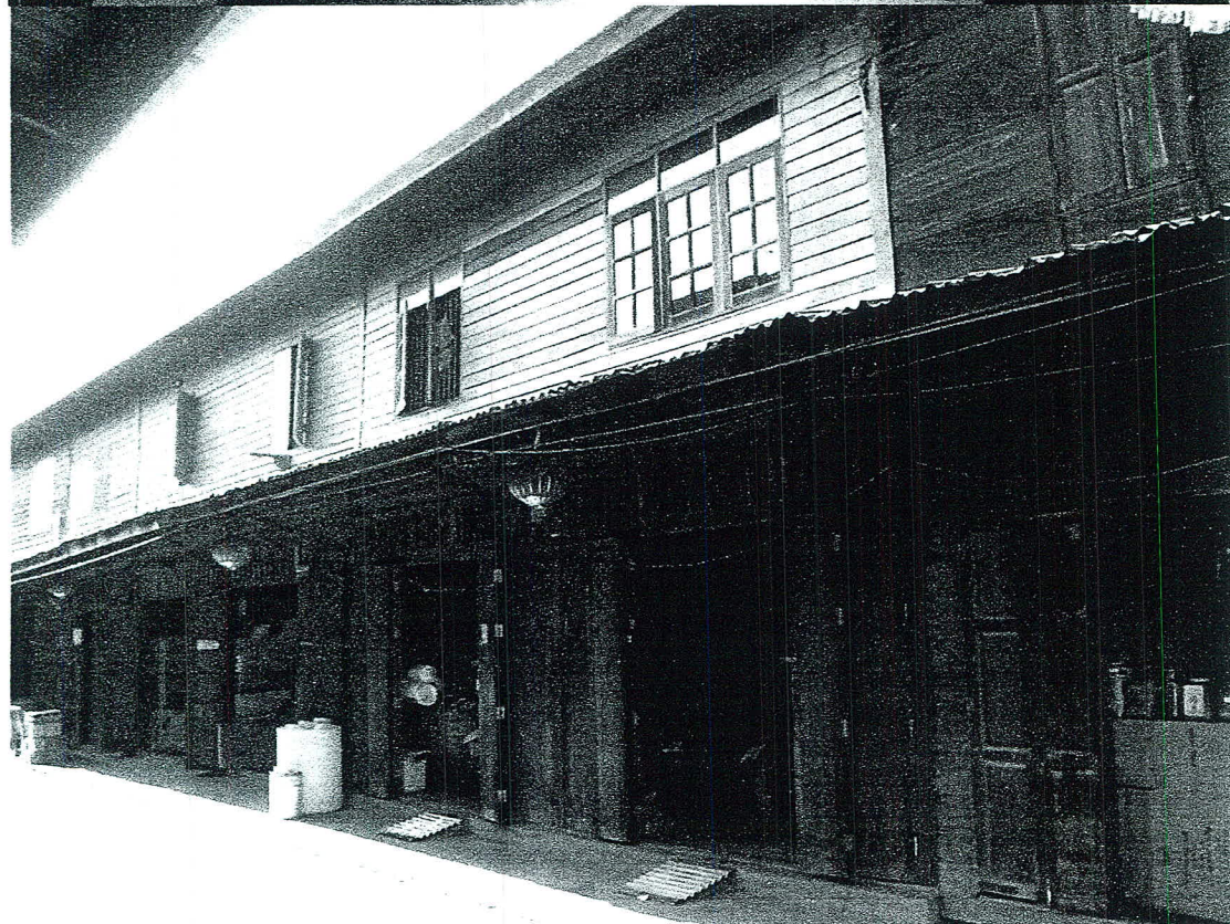
ภาพที่ ก-6 ภาพสภาพบริเวณและอาคารในตลาดบางหลวง
