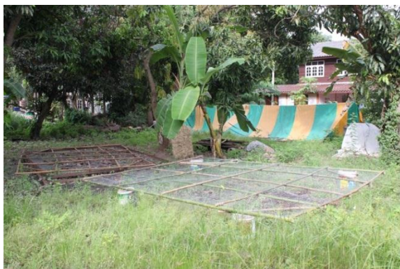
รูปที่ 29 แสดงขั้นตอนในการขึ้นโครงตะแกรงไม้ไผ่
