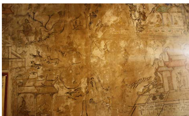
ภาพที่ 33 ภาพจิตรกรรมฝาผนังหลุดลอกอันเกิดจากน้ำฝนที่รั่วไหล
