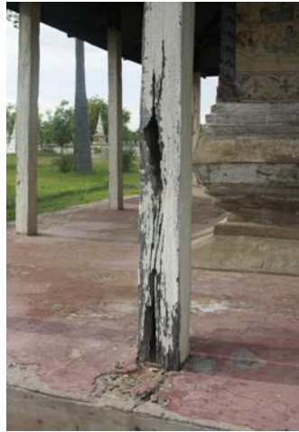
ภาพที่ 55 ความเสียหายของโครงสร้างโบราณสถานวัดป่าเรไรย์
