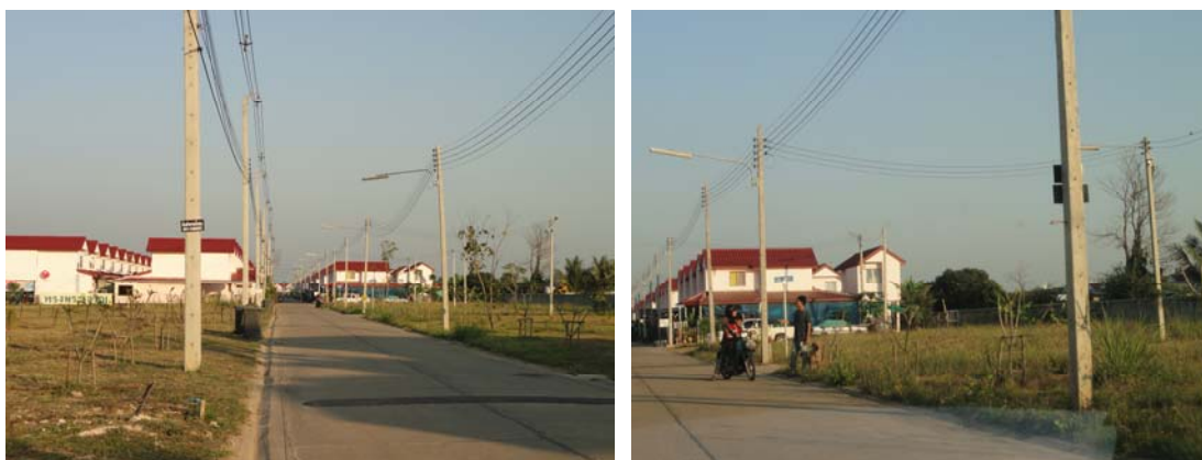
ภาพที่ 34 ถนนสายรองบริเวณตอนต้นโครงการ แยกจากถนนสายหลักเป็นถนน loop ล้อมรอบกลุ่มที่อยู่อาศัยมีแสงสว่างตามแนวทางเดิน และจะเป็นแนวเส้นท่อประปา เสาคู่ไฟฟ้า สภาพแวดล้อมทางกายภาพทั่วไป จะพบว่าผู้อยู่อาศัยต้องใช้ผิวจราจรเป็นทางเดินเท้าแทน (บันทึกภาพวันศุกร์ที่ 14 มกราคม 2554 เวลา 16.15 น.)
