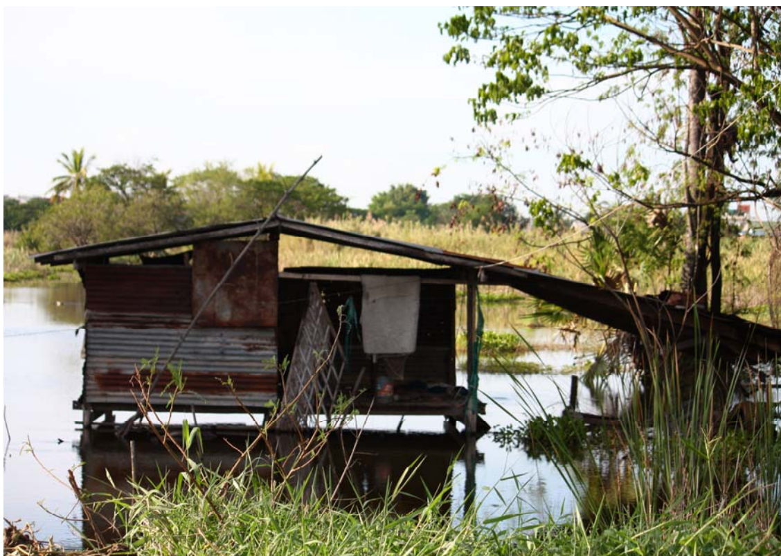
ภาพที่ 24 สถานที่ดำเนินโครงการสำนักงานโครงการจัดรูปที่ดินเพื่อพัฒนาพื้นที่ บริเวณตลาดเทศบาล 5 (ตลาดบ้านคลอง)
