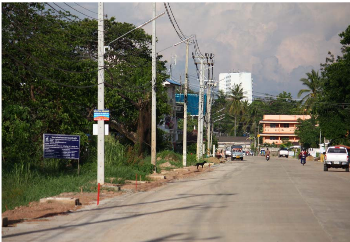
ภาพที่ 27 สถานที่ดำเนินโครงการสำนักงานโครงการจัดรูปที่ดินเพื่อพัฒนาพื้นที่ บริเวณตลาดเทศบาล 5 (ตลาดบ้านคลอง)
