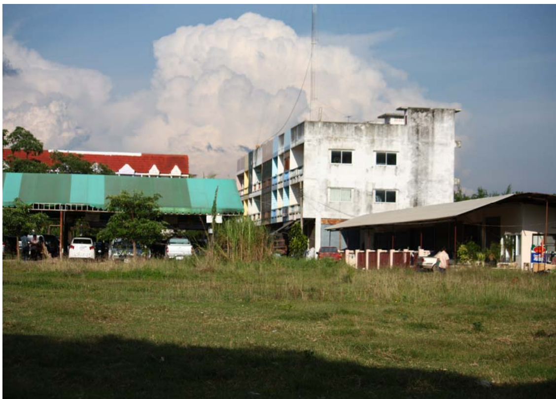
ภาพที่ 23 สถานที่ดำเนินโครงการสำนักงานโครงการจัดรูปที่ดินเพื่อพัฒนาพื้นที่ บริเวณตลาดเทศบาล 5 (ตลาดบ้านคลอง)
