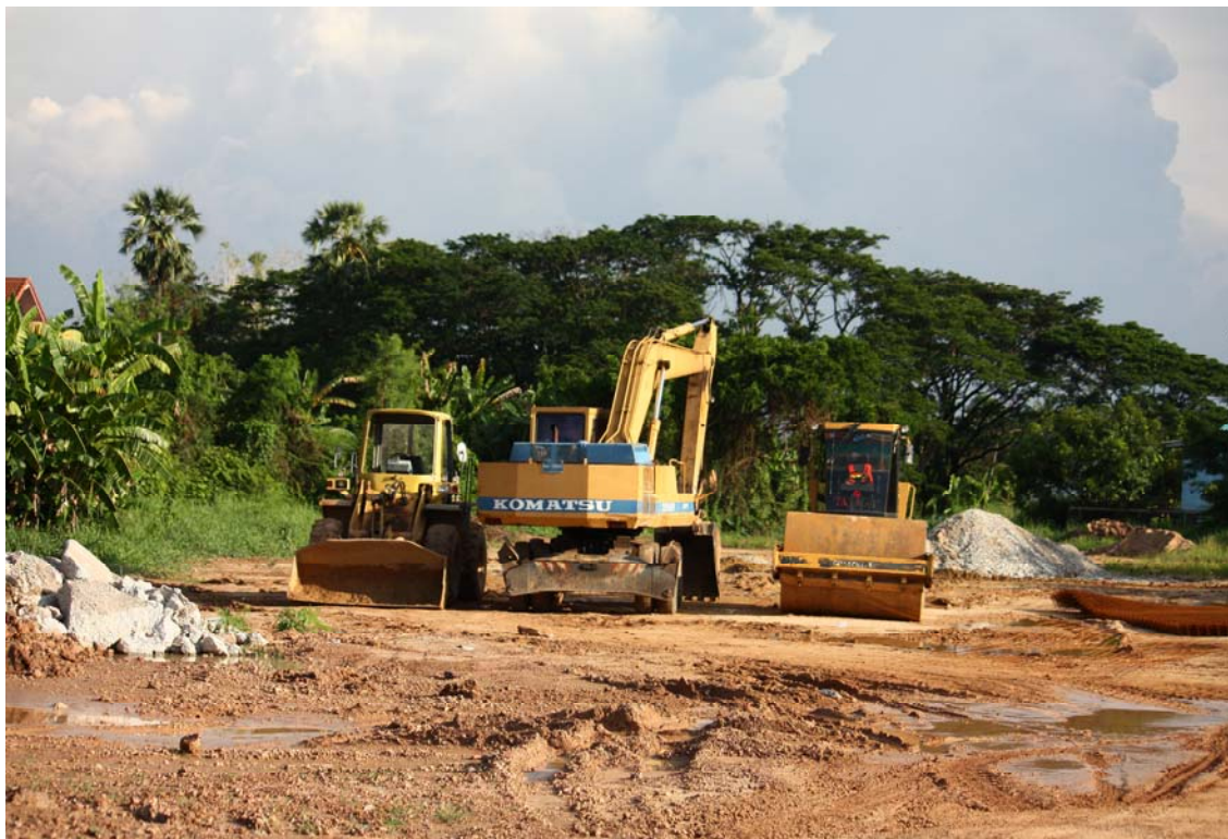
ภาพที่ 25 สถานที่ดำเนินโครงการสำนักงานโครงการจัดรูปที่ดินเพื่อพัฒนาพื้นที่ บริเวณตลาดเทศบาล 5 (ตลาดบ้านคลอง)
