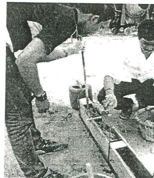
รูปที่ 3.22 การลำเลียงส่วนผสมที่ผสมเสร็จแล้วเข้าแบบหล่อ
