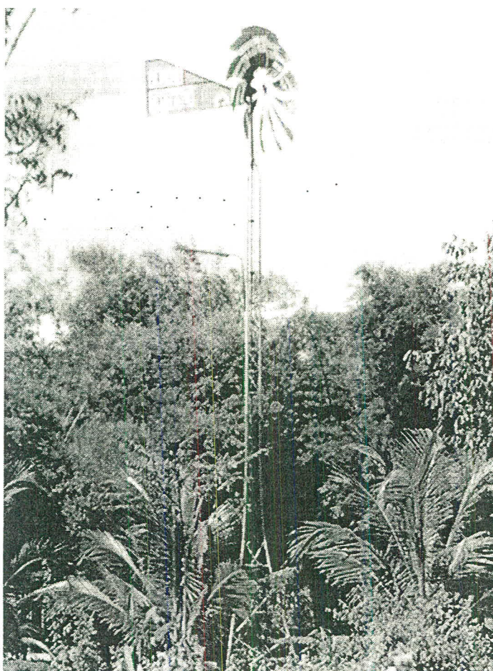
ภาพที่ 13 กังหันลมสูบน้ำ เสาเดียว สวนวิรัตน์ นครราชสีมา
