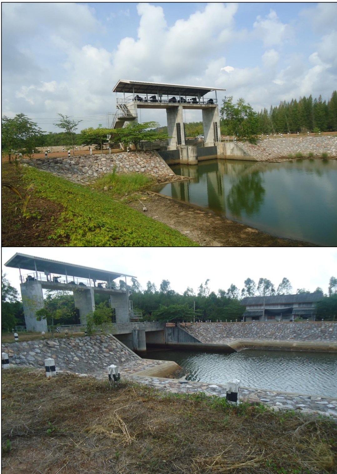
รูปผนวก ง.1 ประตูระบายน้ำคลองชาขุนวิเศษ ต.กองดิน อ.แก่ง จ.ระยอง
