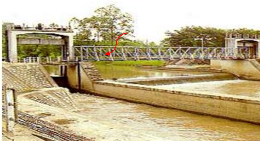
รูปที่ 2.4 ประตูระบายทราย
