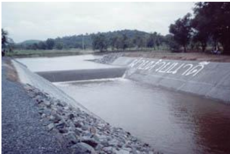
รูปที่ 2.1 ฝายห้วยนาดี อ.แก่งคอย จ.สระบุรี
