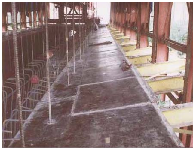
ภาพผนวกที่ 52 การใช้ Recess Formwork (2)
