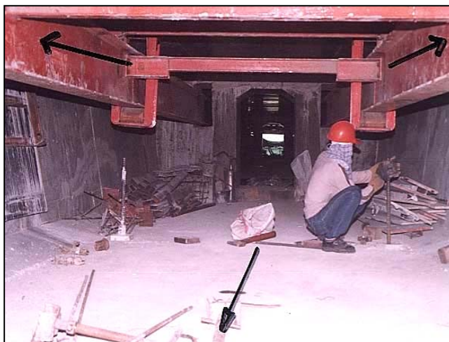
ภาพผนวกที่ ๗๐ การปลด Thread Bar บริเวณ Bottom Slab
