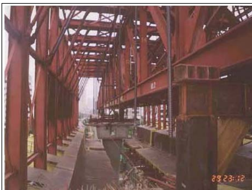
ภาพผนวกที่ ๖๒๙ การเลื่อน Launcher ไปยัง Span ถัดไป
