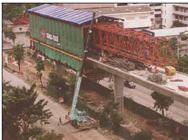
ภาพผนวกที่ ๔๓ การลำเลียง วัสดุ-อุปกรณ์ขึ้น Box-Girder โดย Mobile Crane
