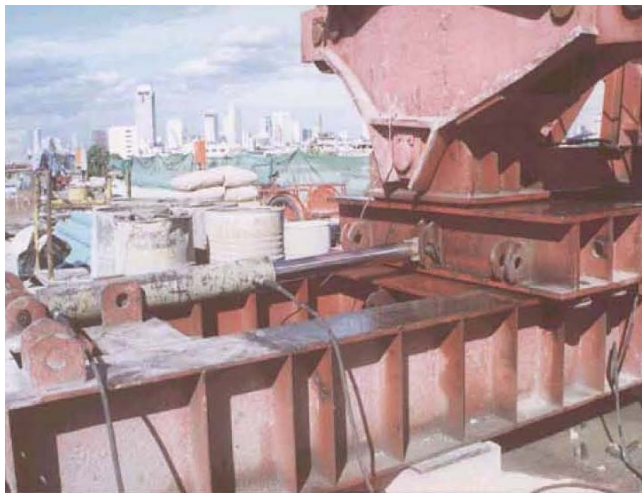
ภาพผนวกที่ ๕๐ การใช้ Side Hydraulic Jack เพื่อดัน Roller Support กรณี Launcher เลื่อนตัว ในแนวโค้ง (2)
