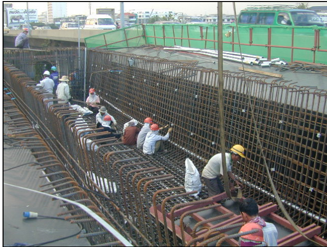
ภาพผนวกที่ ง116 ติดตั้งอุปกรณ์ลวดอัดแรง (Post Tension) ใน Webs
