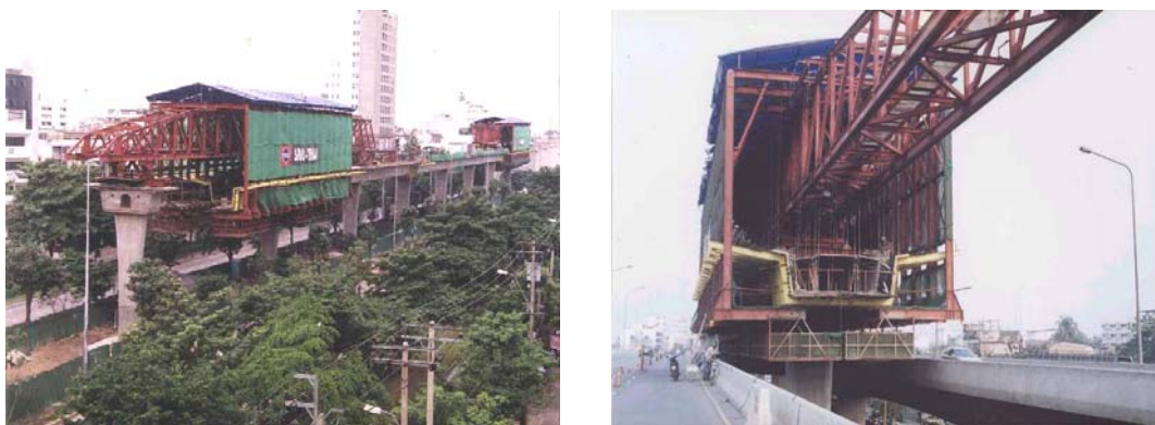
ภาพผนวกที่ ๑5 Launcher แบบ Top Running Type ที่ใช้ในโครงการทางยกระดับคลองภาษีเจริญ และส่วนต่อเนื่อง ตอนที่ 2
