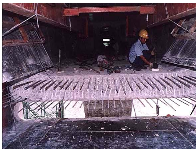
ภาพผนวกที่ ๓๔ ติดตั้ง Thread Bar ของ Rear Bottom Frame 2 ตัวใน Box-Girder
