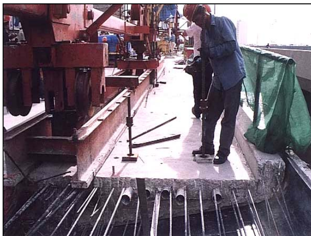
ภาพผนวกที่ 87 Thread Bar ยึด Drivedeck บน Deck Slab
