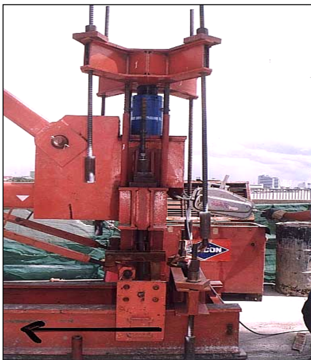
ภาพผนวกที่ 74 การถอน Coupler บริเวณ Rear Anchorage
