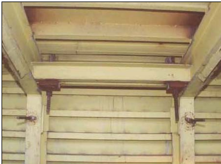
ภาพผนวกที่ ๓๓๘ การยึด Hanger Rod ใต้ Outer Formwork
