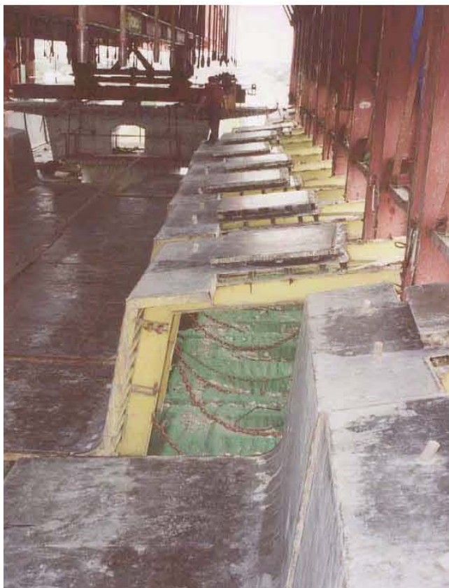
ภาพผนวกที่ ๕๑ การใช้ Recess Formwork (1)
