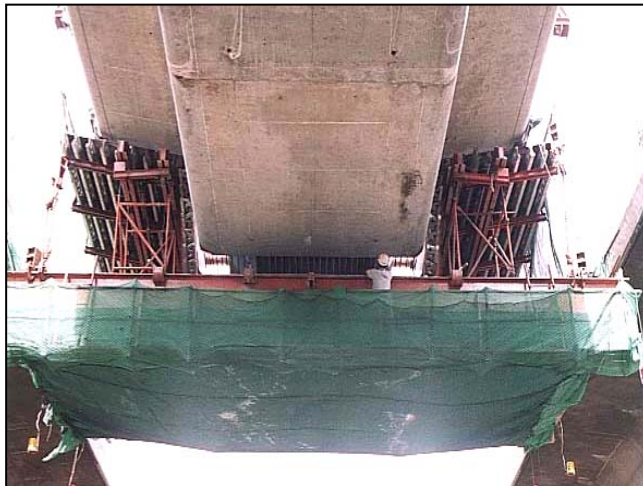
ภาพผนวกที่ ๓85 เตรียมยึด Bottom Frame กับ Bottom Slab
