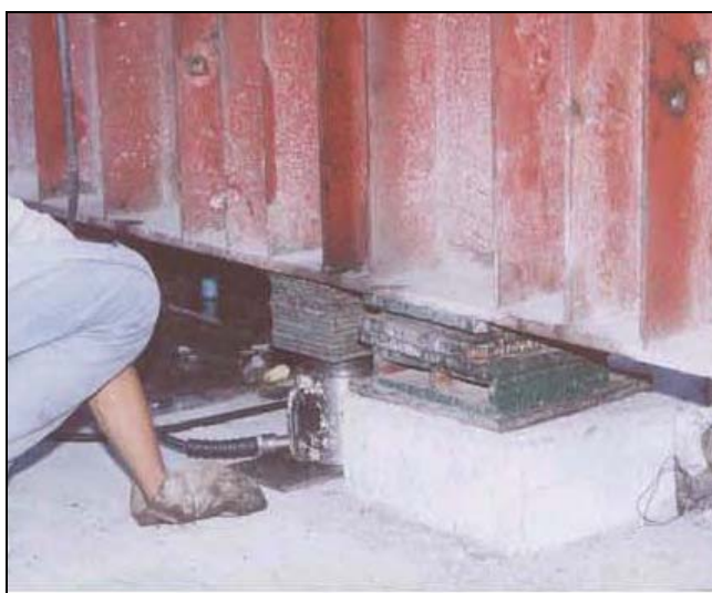
ภาพผนวกที่ ๔๔ การยก Roller Support โดยใช้ Pancake Hydraulic Jack และ Shim ด้วยแผ่นเหล็ก กรณีการเลื่อน Launcher ในแนวเอียงขึ้นและเอียงลง
