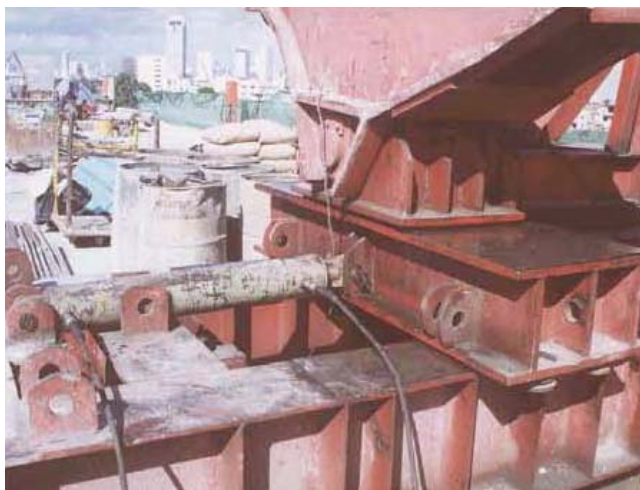
ภาพผนวกที่ ๔๑๑ การใช้ Side Hydraulic Jack เพื่อดัน Roller Support กรณี Launcher เลื่อนตัว ในแนวโค้ง (1)
