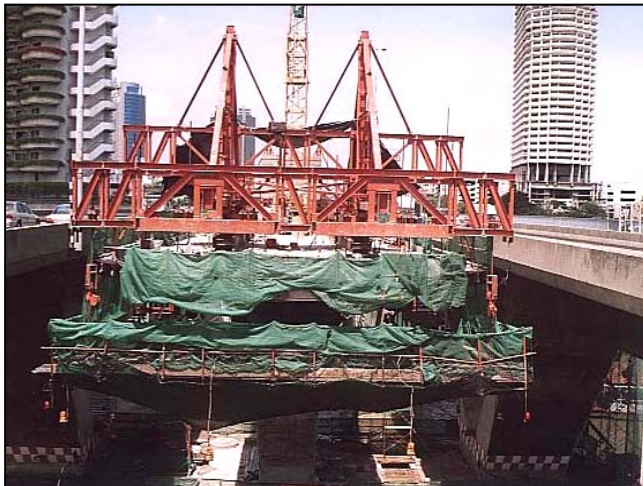
ภาพผนวกที่ ๙๐ From Traveler สภาพพร้อมเทคอนกรีต
