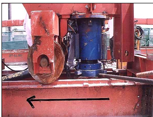
ภาพผนวกที่ 75 ลดระดับ Hydraulic Jack จนลูกล้อสัมผัสราง
