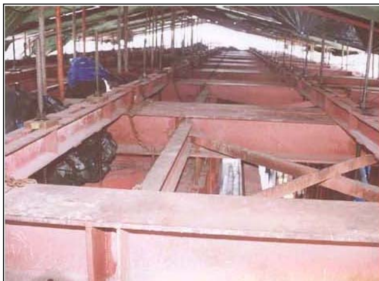
ภาพผนวกที่ ๓37 การติดตั้ง Hanger Rod บริเวณ Anchor บน Hanger Frame
