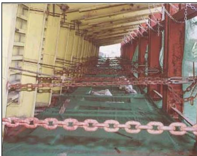
ภาพผนวกที่ ๓๔๐ จัดแนว Outer Formwork ด้วยโซ่
