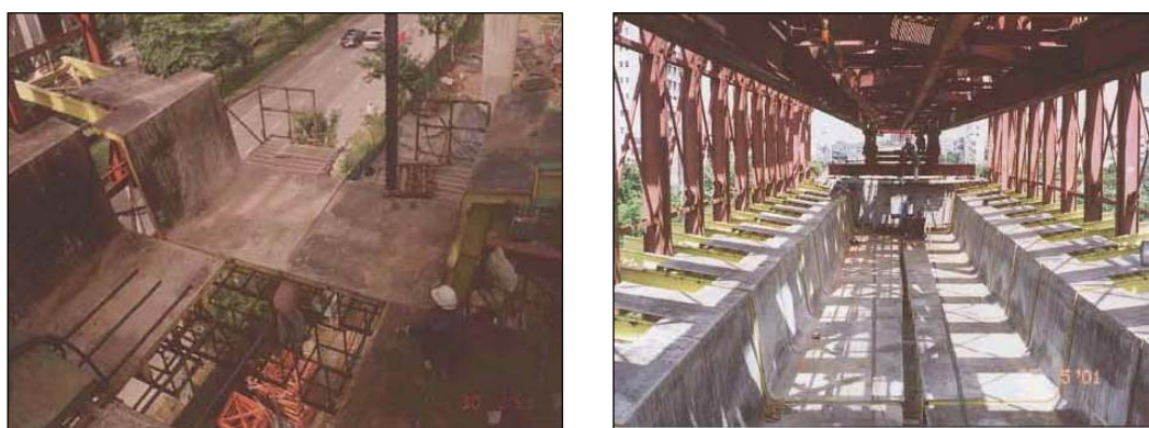
ภาพผนวกที่ 34 ประกอบ outer Formwork เมื่อ Launcher ถึง ตำแหน่ง
