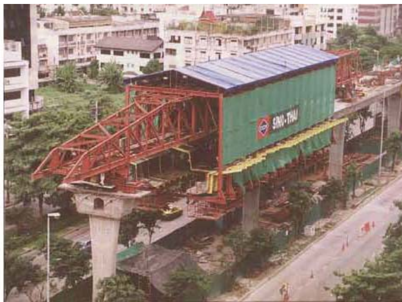
ภาพผนวกที่ ๖๒๘ การแยก Outer Formwork และ Working Platform เตรียมเลื่อน Launcher
