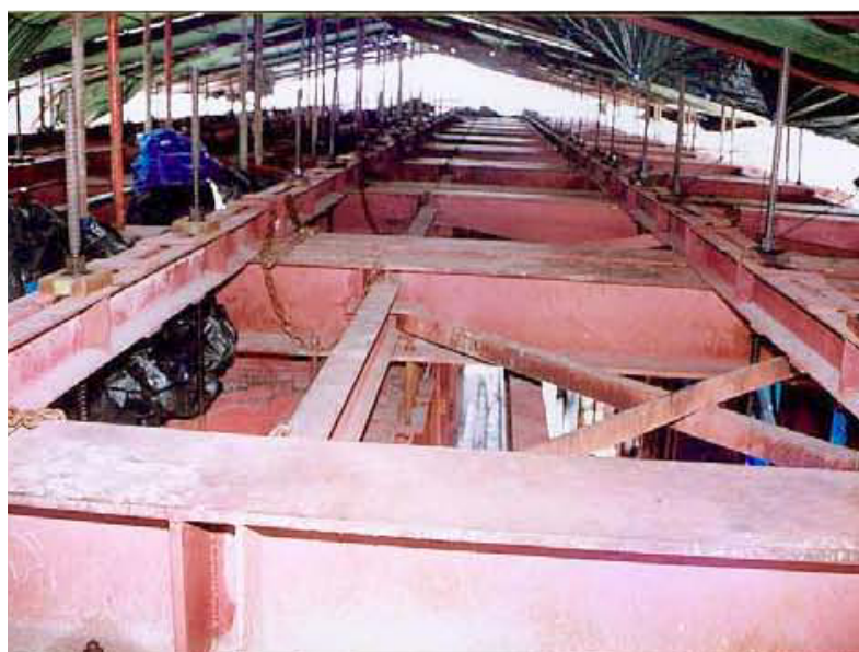
ภาพผนวกที่ 16 การติดตั้ง Hanger Bar Anchor และ Hanger Rod บน Top Beam ของ Hanger Frame
