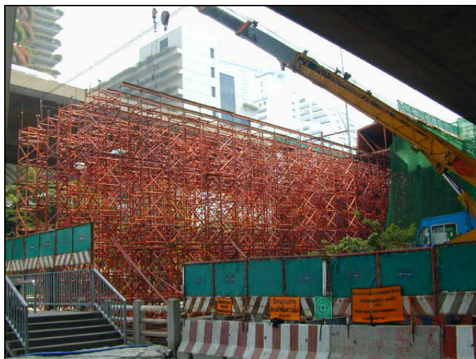
ภาพผนวกที่ 113 ติดตั้งนั่งร้านบน Support เพื่อรองรับแบบหล่อ
