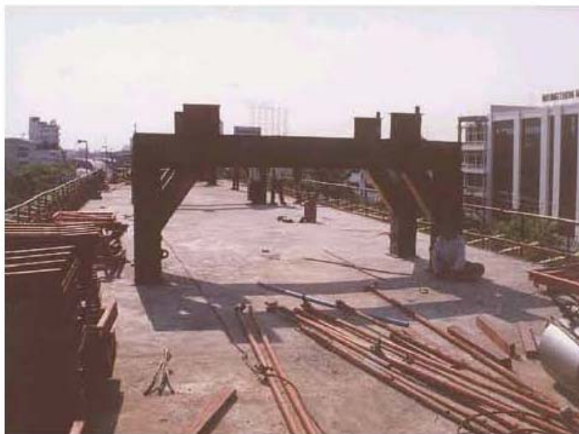
ภาพผนวกที่ 12 การติดตั้ง Temporary Support เพื่อรองรับส่วนของ Main Girder บน Box-Girder Span แรก
