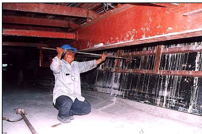
ภาพผนวกที่ ๖๒ การถอน Tie Rod ที่ Out Web Formwork
