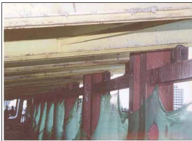
ภาพผนวกที่ 35 ลูกถ้วยรับ Outer Formwork ที่ Vertical Beam
