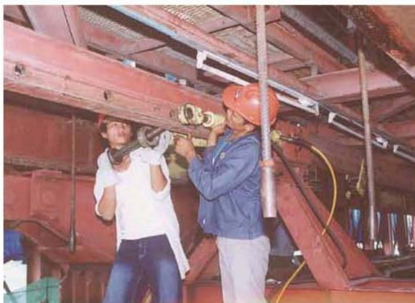
ภาพผนวกที่ 30 ขั้นตอนการทำงานของ Main Hydraulic Jack ในการขับเคลื่อน Launcher ( Step 1)
