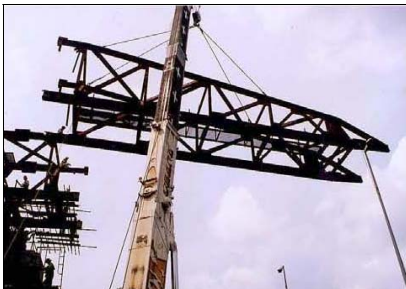
ภาพผนวกที่ 14 การติดตั้ง Main Girder ท่อน Nose (A) ด้วย Mobile Crane
