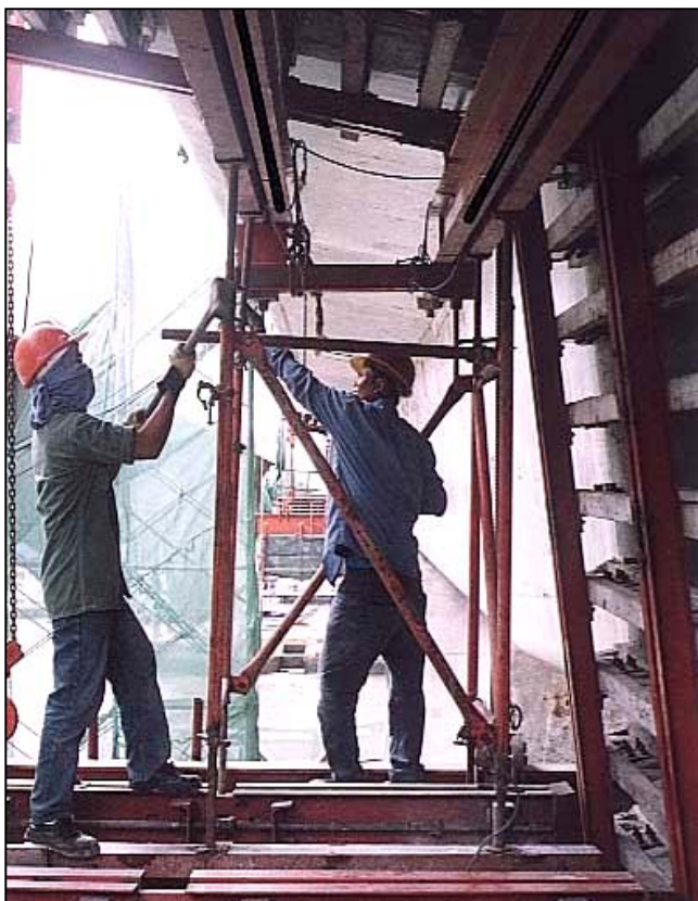
ภาพผนวกที่ ๖7 การติดตั้งนั่งร้านรองรับ Outer Formwork
