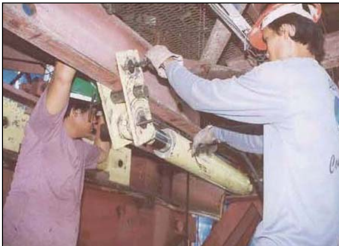
ภาพผนวกที่ ๓45 การใช้ Breaking Hydraulic Jack
