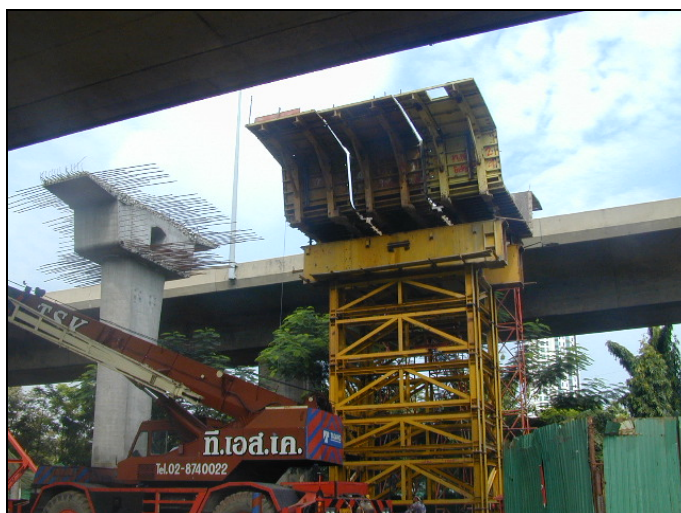
ภาพผนวกที่ ๙๘ ประกอบแบบหล่อ Advance Segment
