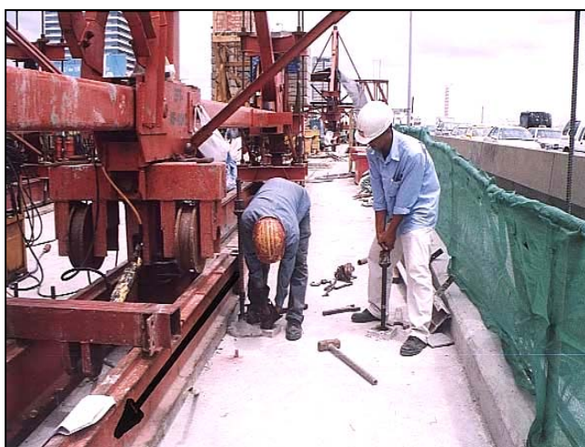
ภาพผนวกที่ ๖9 การปลด Thread Bar บริเวณ Deck Slab
