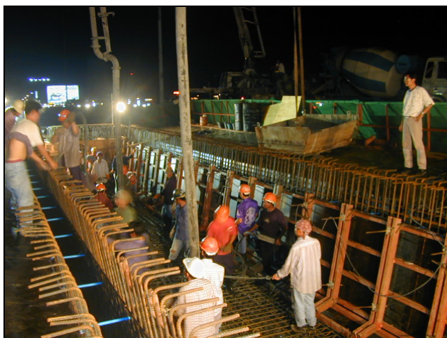
ภาพผนวกที่ ง117 ปิดแบบ Webs พร้อมเทคอนกรีต Bottom Slab & Webs
