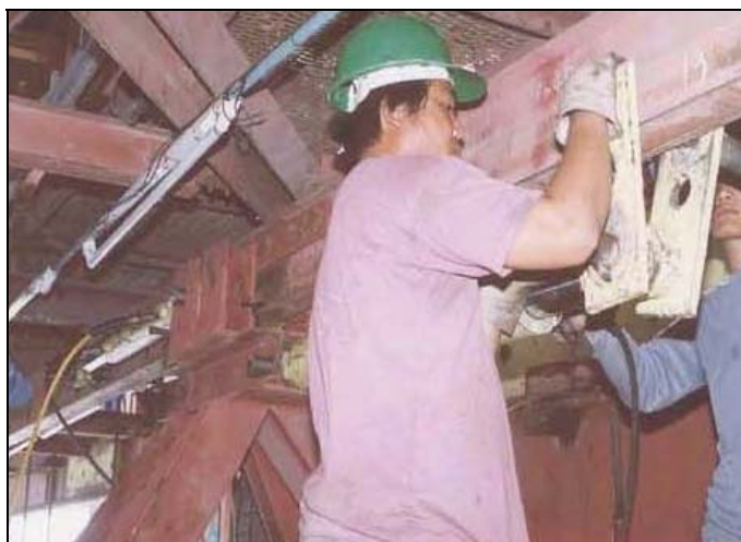
ภาพผนวกที่ ๓46 การใช้ Breaking Hydraulic Jack
