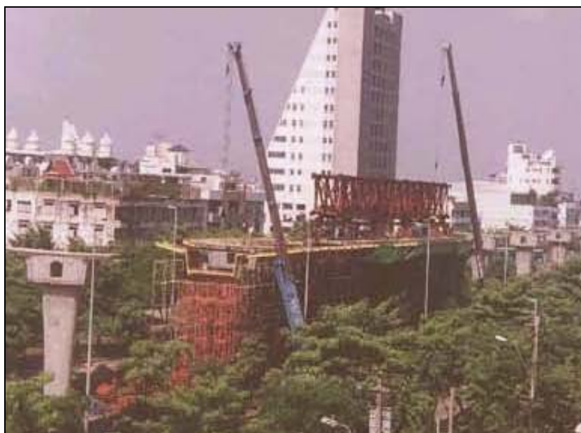
ภาพผนวกที่ 13 การยกส่วนของ Main Girder ขึ้นวางบน Temporary Support เพื่อประกอบ
