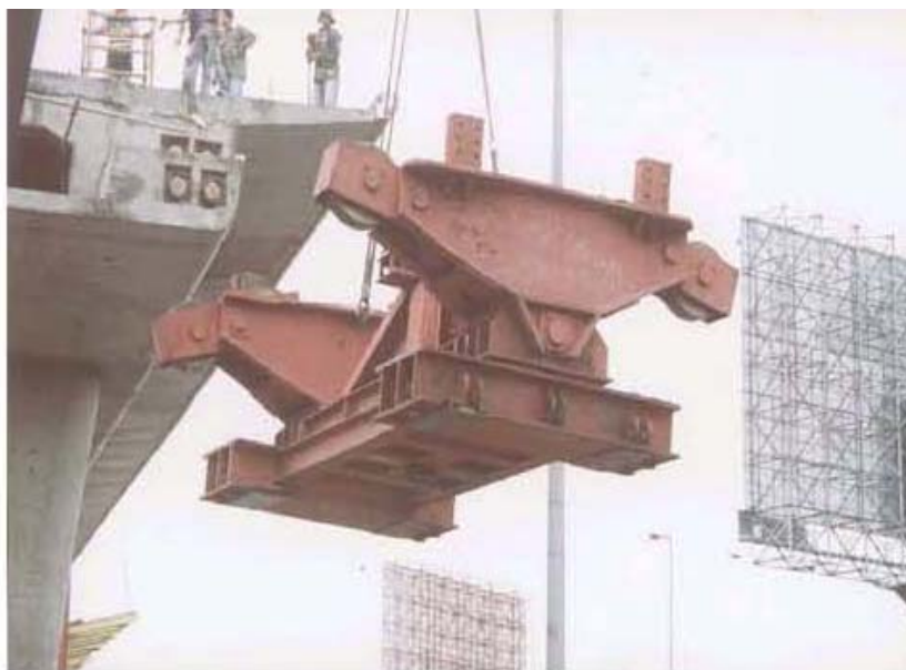
ภาพผนวกที่ 26 การยก Roller Support ขึ้นไปติดตั้งบน Cross Head
