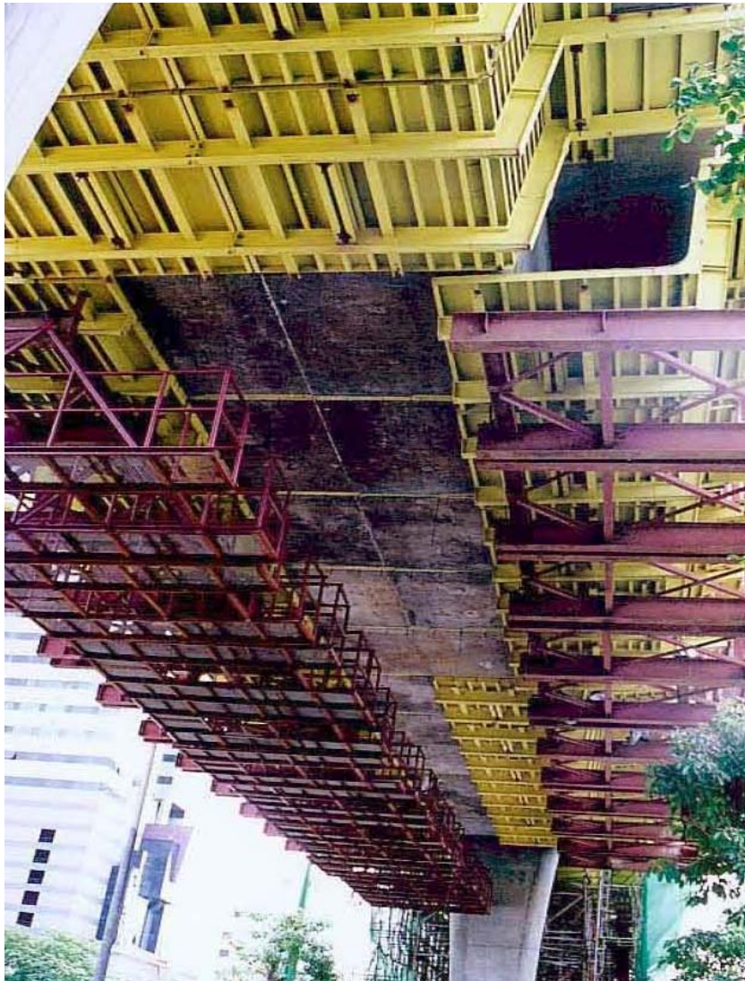
ภาพผนวกที่ ๑17 การติดตั้ง Working Platform และการปิด Outer Formwork ลงวางบน Hanger Frame
