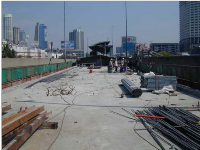
ภาพผนวกที่ 118 Deck Slab ที่ทำการเทคอนกรีตแล้ว
