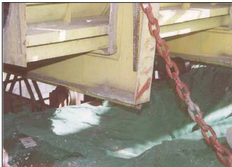
ภาพผนวกที่ ๓36 ลูกตั้งรับ Outer Formwork ที่ Bottom Beam
