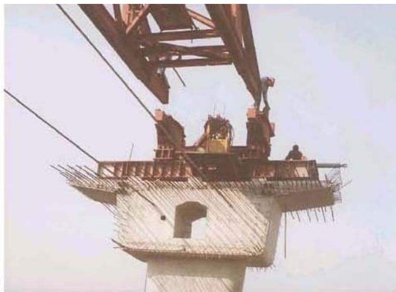
ภาพผนวกที่ 27 การติดตั้ง PC Strand แล้ว Pre-Stressing ยึดรั้ง Cross Head
