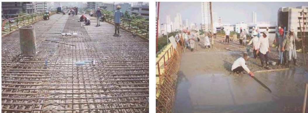
ภาพผนวกที่ 11 การติดตั้งเหล็กเสริมและเทคอนกรีต Deck Slab
