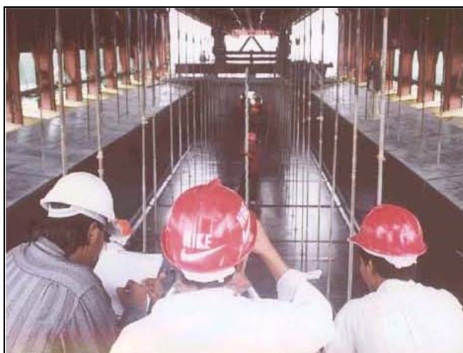
ภาพผนวกที่ ๓๔๑ ตรวจสอบระดับ Outer Formwork
