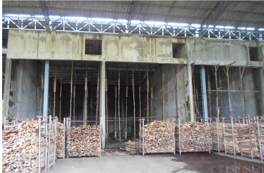
รูปที่ 5.25 เตาอบไม้ยางพาราที่กำลังก่อสร้าง
