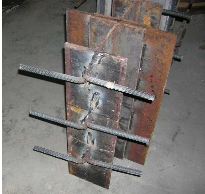
รูปที่ 3.1 นำ Shear Connector ที่ตัดเสร็จแล้วเชื่อมมาติดกับคานเหล็ก
