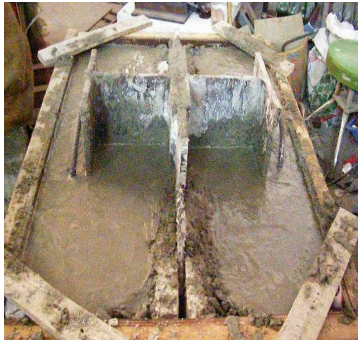
รูปที่ ๕.๖ เทคอนกรีตทับหน้าและใช้เครื่องเขย่าจี้เป็นระยะเพื่อไม่ให้เกิดช่องว่างจนกระทั่งเทคอนกรีตเสร็จ
