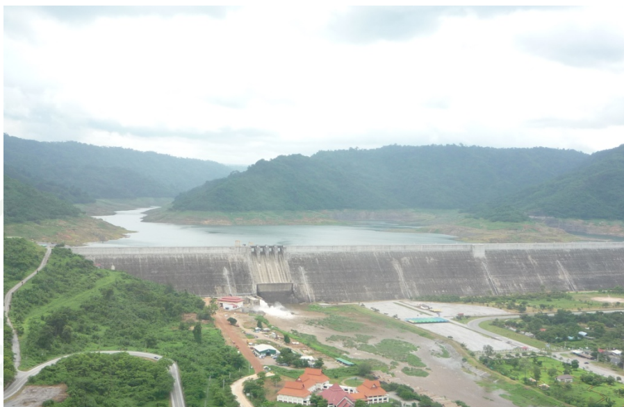
ภาพที่ 3.1 เขื่อนขุนด่านปราการชล บ้านท่าด่าน ตำบลหินตั้ง อำเภอเมือง จังหวัดนครนายก ที่มา: จังหวัดนครนายก (2556)
