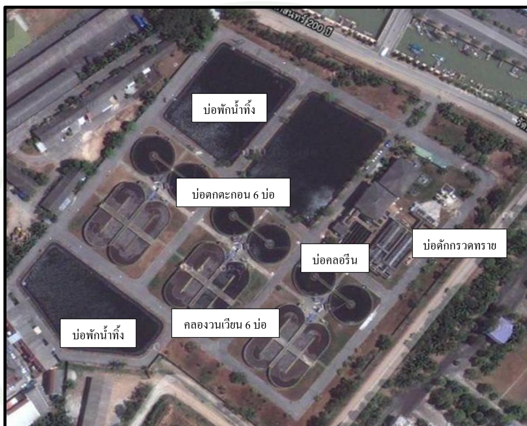
ภาพที่ 1 ระบบบำบัดน้ำเสียแบบคลองวนเวียนเทศบาลนครภูเก็ต จังหวัดภูเก็ต
