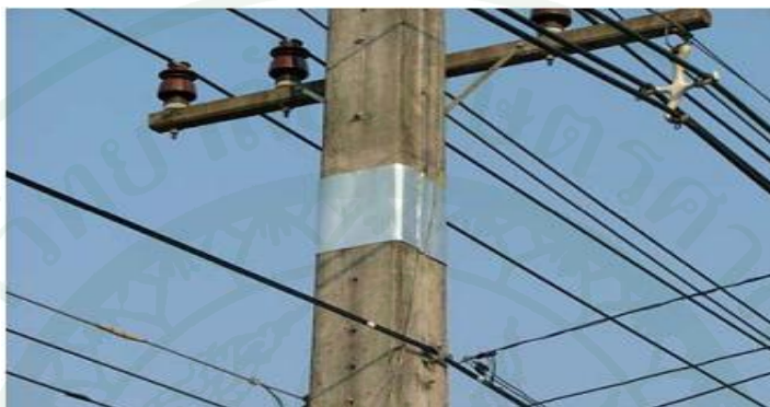
ภาพที่ 20 อุปกรณ์ป้องกันงูแบบแผ่นโลหะ
