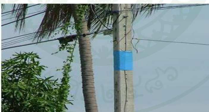
ภาพที่ 21 อุปกรณ์ป้องกันงูแบบแผ่นพลาสติก
