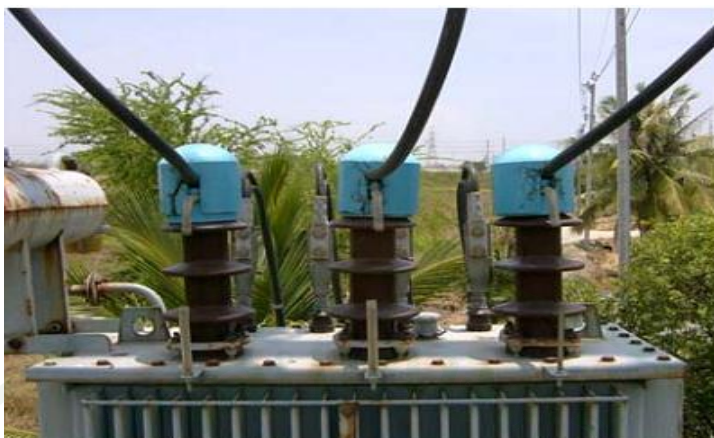
ภาพที่ 23 อุปกรณ์ป้องกันแบบหวัครอบพีวีซีครอบที่หัวบุขซึ่งของหม้อแปลง
