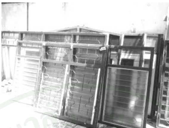
ภาพผนวกที่ ๑1 วงกบน้ำต่างและบานเกล็ดจากการรื้อถอน
