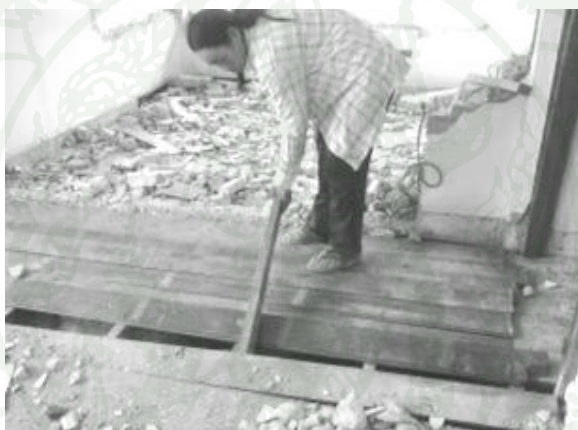
ภาพผนวกที่ จ10 การรื้อพื้นไม้ชั้น 2
