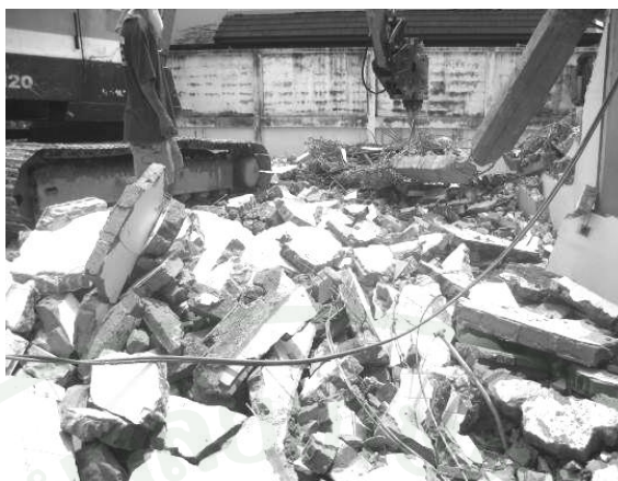
ภาพผนวกที่ ๑๑ ลักษณะของคอนกรีตที่ถูกรื้อถอนและบดอัดเพื่อให้มีขนาดเล็กลง
