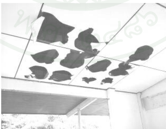
ภาพผนวกที่ จ6 ลักษณะของฝ้าเพดานที่ถูกรื้อถอนบางส่วน
