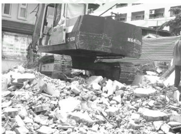
ภาพผนวกที่ ๙ ลักษณะของคอนกรีตจากการรื้อถอนก่อนทำการบดย่อย
