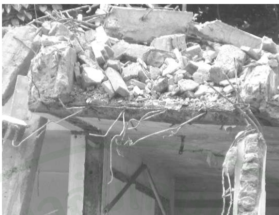
ภาพผนวกที่ ๗ ลักษณะของโครงสร้างคอนกรีตและโครงสร้างเหล็กที่ถูกรื้อถอน
