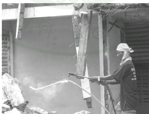
ภาพผนวกที่ จ17 การตัดแยกส่วนของโครงสร้างเหล็ก
