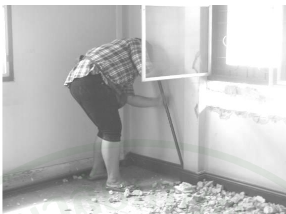
ภาพผนวกที่ จ9 การรื้อถอนส่วนของไม้ที่ตกแต่งภายใน
