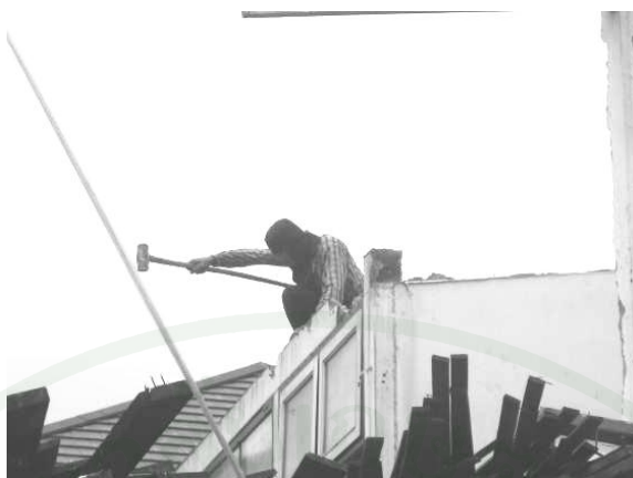
ภาพผนวกที่ จ12 การรื้อถอนโครงสร้างหลังคา
