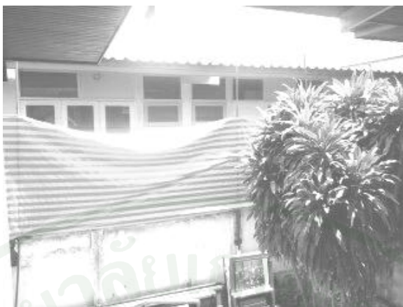
ภาพผนวกที่ จ1 การติดตั้งอุปกรณ์ป้องกันล๊อมรอบพื้นที่รื้อถอน
