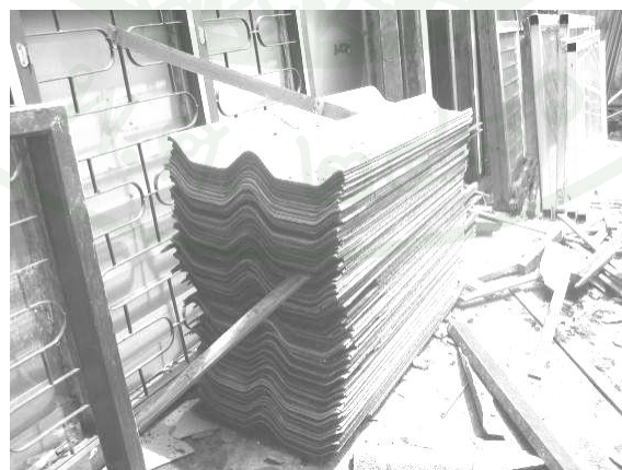
ภาพผนวกที่ ๑3 กระเบื้องหลังคาจากการรื้อถอน
