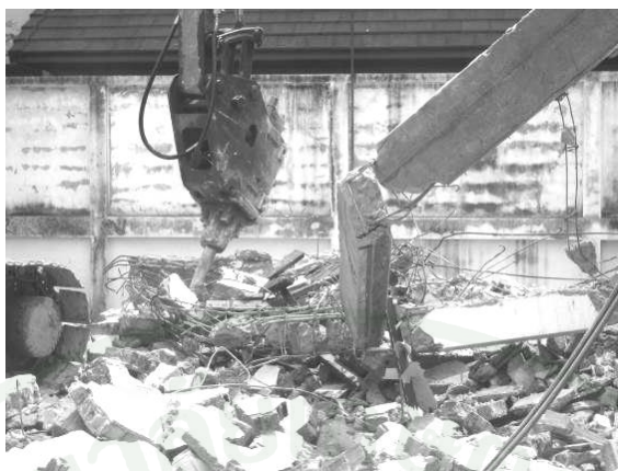
ภาพผนวกที่ จ18 การรื้อส่วนของโครงสร้างเหล็กออกจากคอนกรีต
