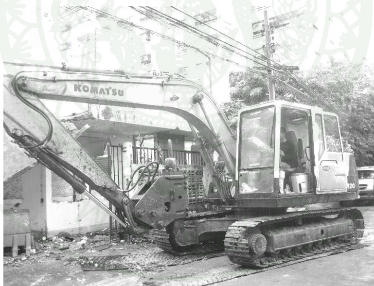
ภาพผนวกที่ ข2 รถแบ็คโฮที่ใช้ในการรื้อถอนโครงสร้างคอนกรีต
