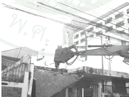
ภาพผนวกที่ จ14 การรื้อถอนโครงสร้างคอนกรีต (ก)
