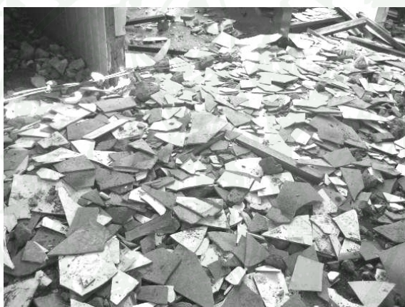
ภาพผนวกที่ ๕ ลักษณะของฝ้าเพดานและแผ่นยิปซัมจากการรื้อถอน
