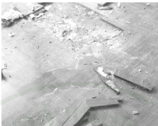
ภาพผนวกที่ ๔ พื้นไม้ปาร์เก้จากการรื้อถอน
