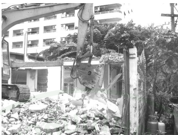
ภาพผนวกที่ จ15 การรื้อถอนโครงสร้างคอนกรีต (ข)
