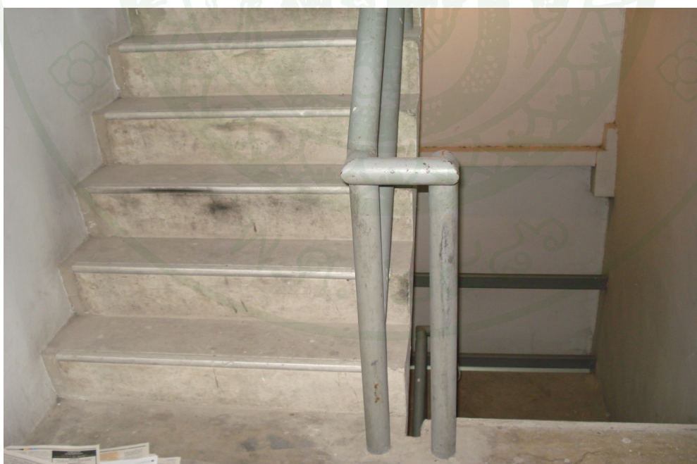
ภาพที่ 34 แสดงราวจับบันไดหนีไฟ FST-1 & 3 ที่มี 1 ด้าน แต่ไม่ควรติดตั้งเพิ่ม
