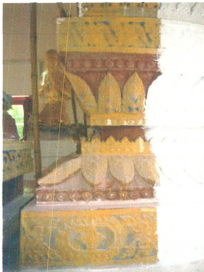
ภาพที่ 50 สภาพสีที่ระบายด้วยสีฝุ่นที่ถูกความชื้นทำลายชั้นสี (ก่อนการบูรณะ)
