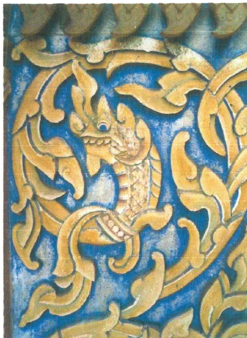
ภาพที่ 51 ลวดลายที่ระบายด้วยสีฝุ่นที่โดนแสงแดดทำให้สีหลุดและซีดจาง (ก่อนการบูรณะ)
