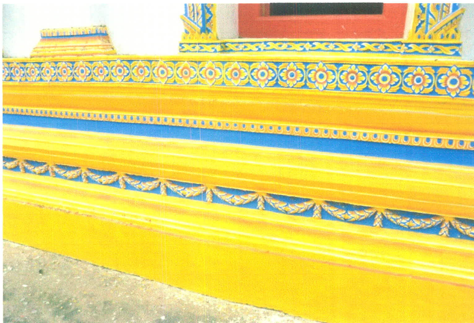
ภาพที่ 61 สีที่ซีดจางลงเพราะแสงแดดและร่องรอยของความเสียหายที่เกิดจากมูลของนก บริเวณฐานพระอุโบสถ
