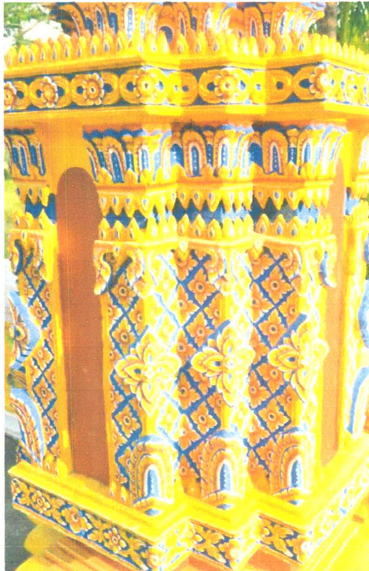
ภาพที่ 62 สีที่ขีดจางลงเพราะแสงแดด (โดยเฉพาะสีน้ำเงิน)
