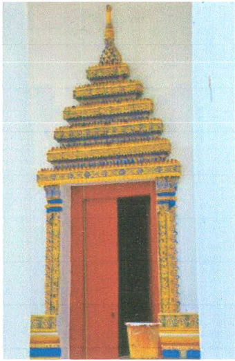
ภาพที่ 34 การทดลองใช้วัสดุทดแทน ชุ่มประตูประอุโบสถ(แดดส่องตอนบ่าย-ซ้าย)
