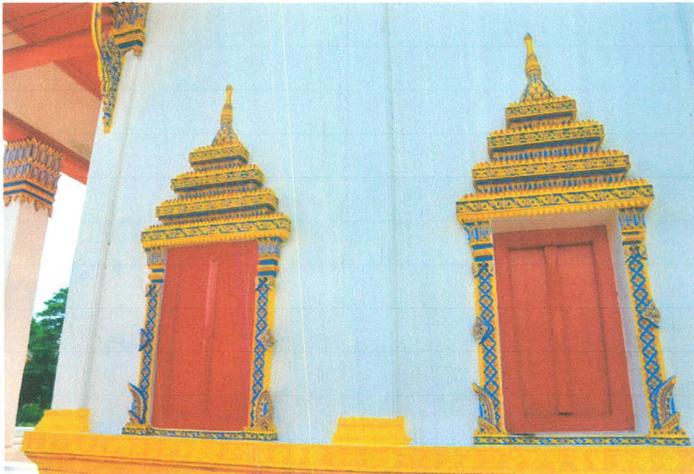
ภาพที่ 32 การทดลองใช้วัสดุทดแทน ชุ่มหน้าต่างพระอุโบสถ(แดดส่องตอนบ่าย)
