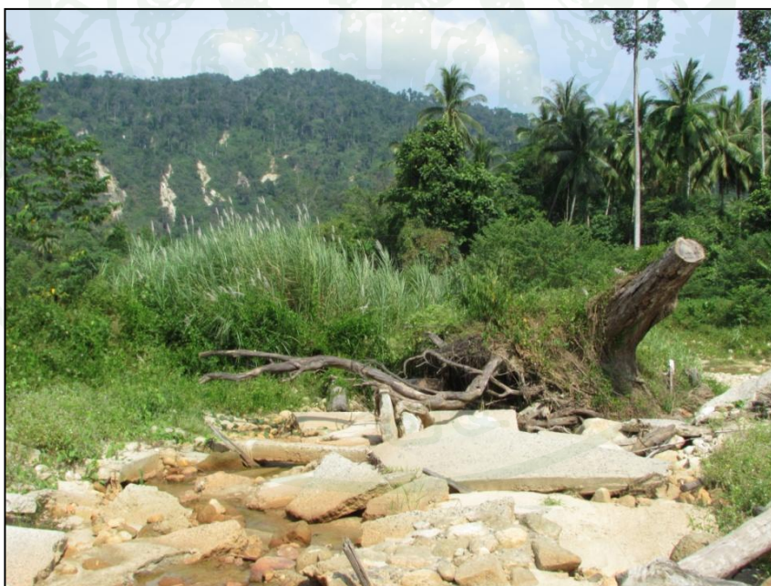
ภาพผนวกที่ ค2 ถนนคอนกรีตที่ได้รับความเสียหายจากอุทกภัยในปี พ.ศ. 2554
