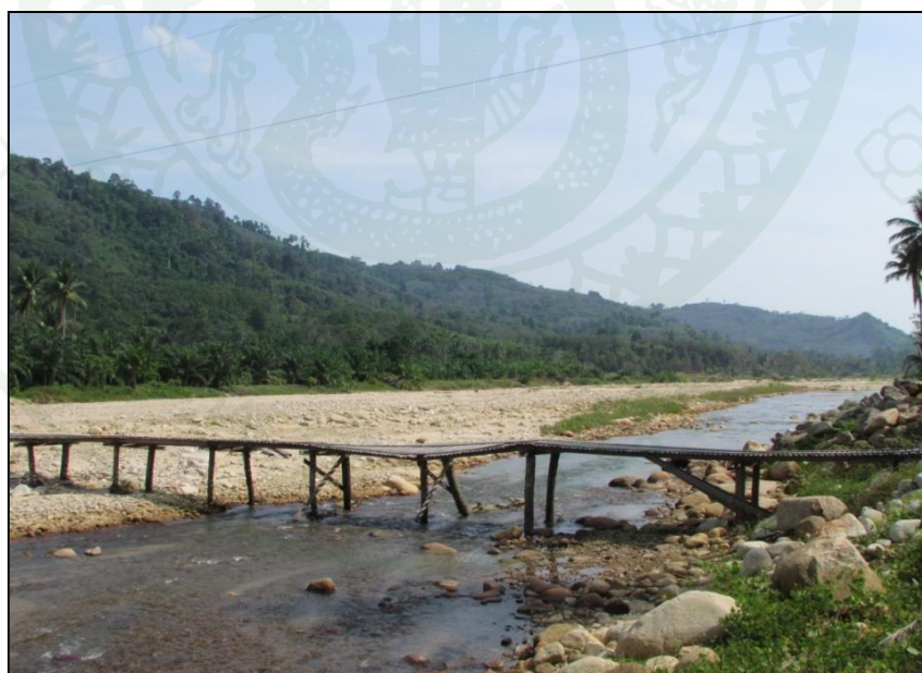
ภาพผนวกที่ ค4 สะพานชั่วคราวในหมู่ที่ 10 บ้านเขียนบน ตำบลเทพราช ที่ทางทหารช่างสร้างไว้ หลังจากที่สะพานเดิมได้รับความเสียหายอุทกภัยในปี พ.ศ. 2554
