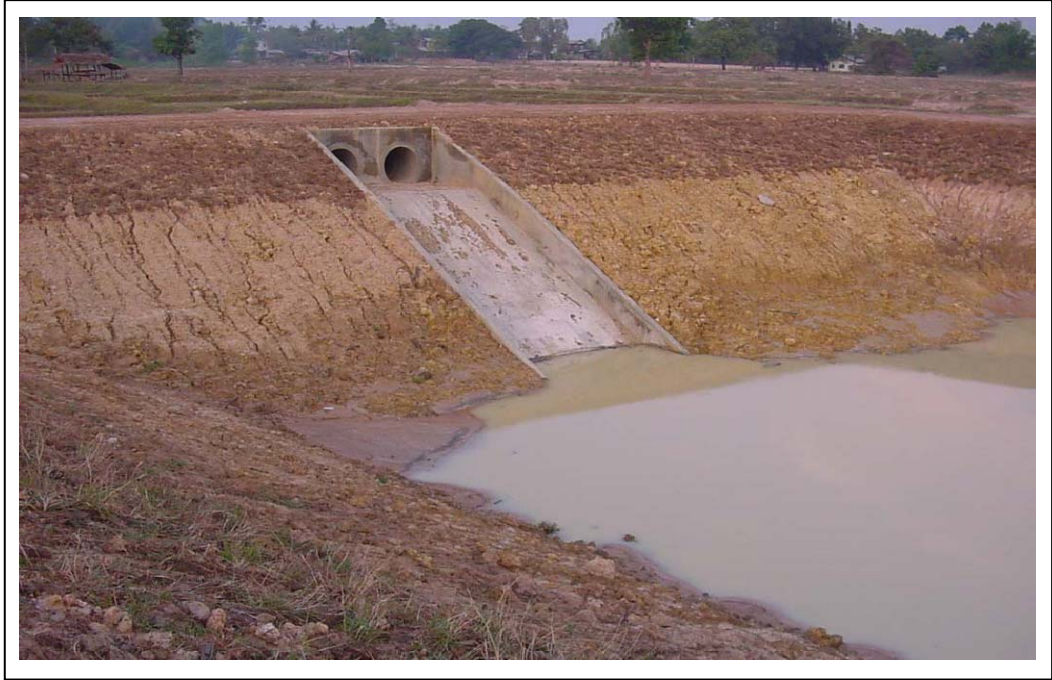
รูปที่ ๑.๒ อาคารทางน้ำเข้าสู่สระเก็บน้ำ [25]
