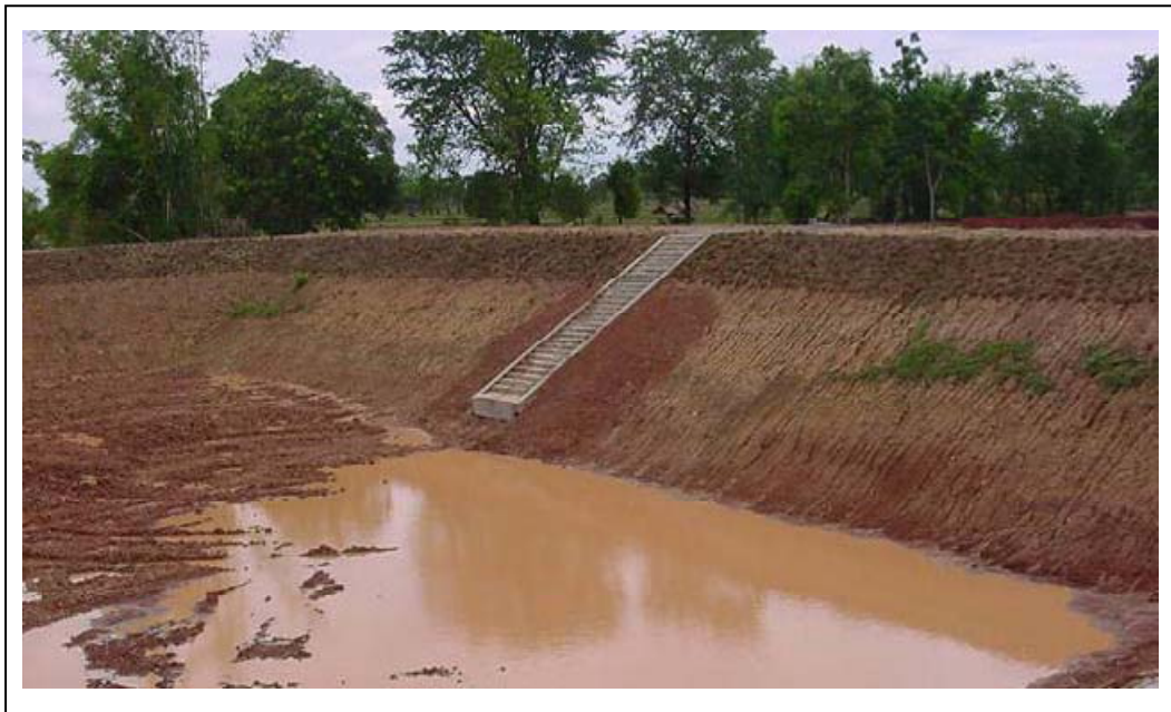
รูปที่ ๑.๓ บันไดลงสระเก็บน้ำ [25]
