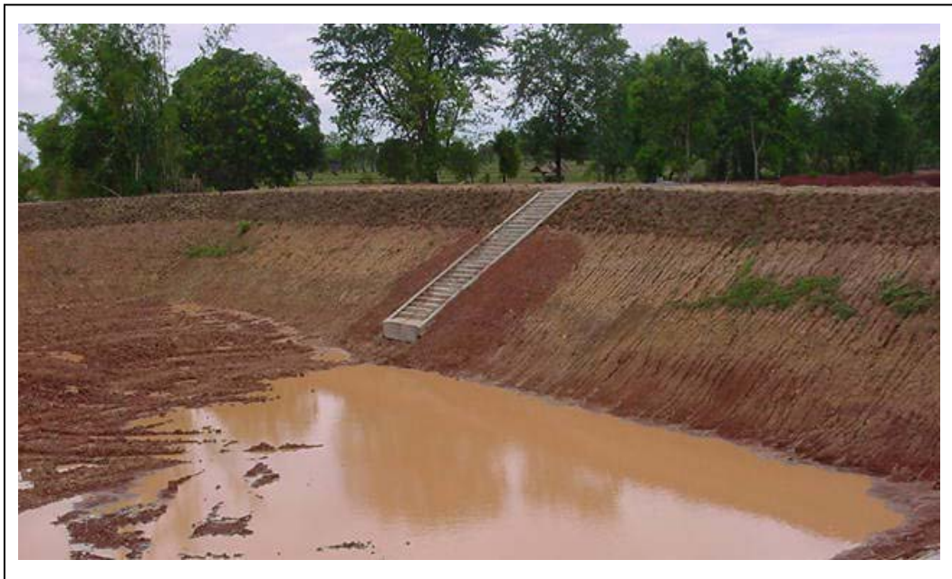
รูปที่ ค.3 บันไดลงสระเก็บน้ำ [25]
