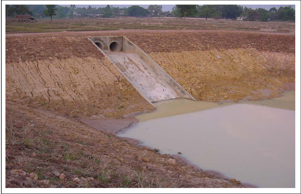
รูปที่ ค.2 อาคารทางน้ำเข้าสู่สระเก็บน้ำ [25]
