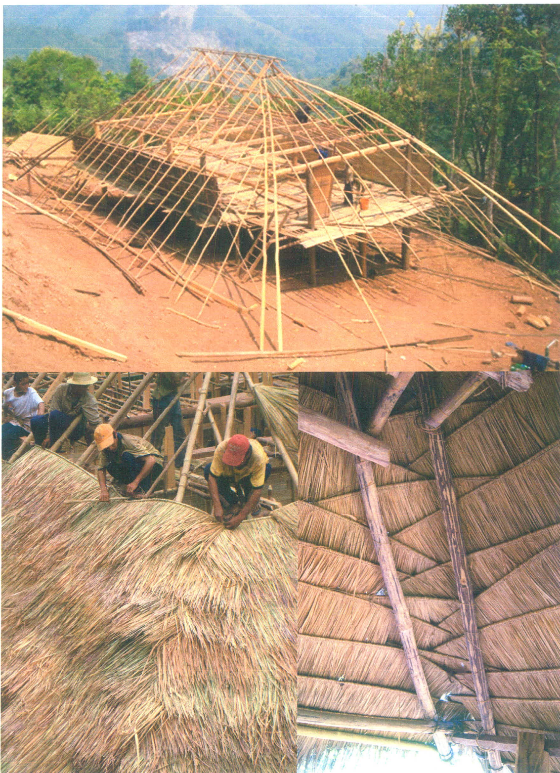
ภาพที่ 4.34 แสดงการมุงหลังคาบริเวณลำแคเรือนชาวปรี บ้านปากำ ที่มา : จากการเก็บข้อมูลภาคสนามโดย สัญชัย สุพิพัฒน์มงคล
