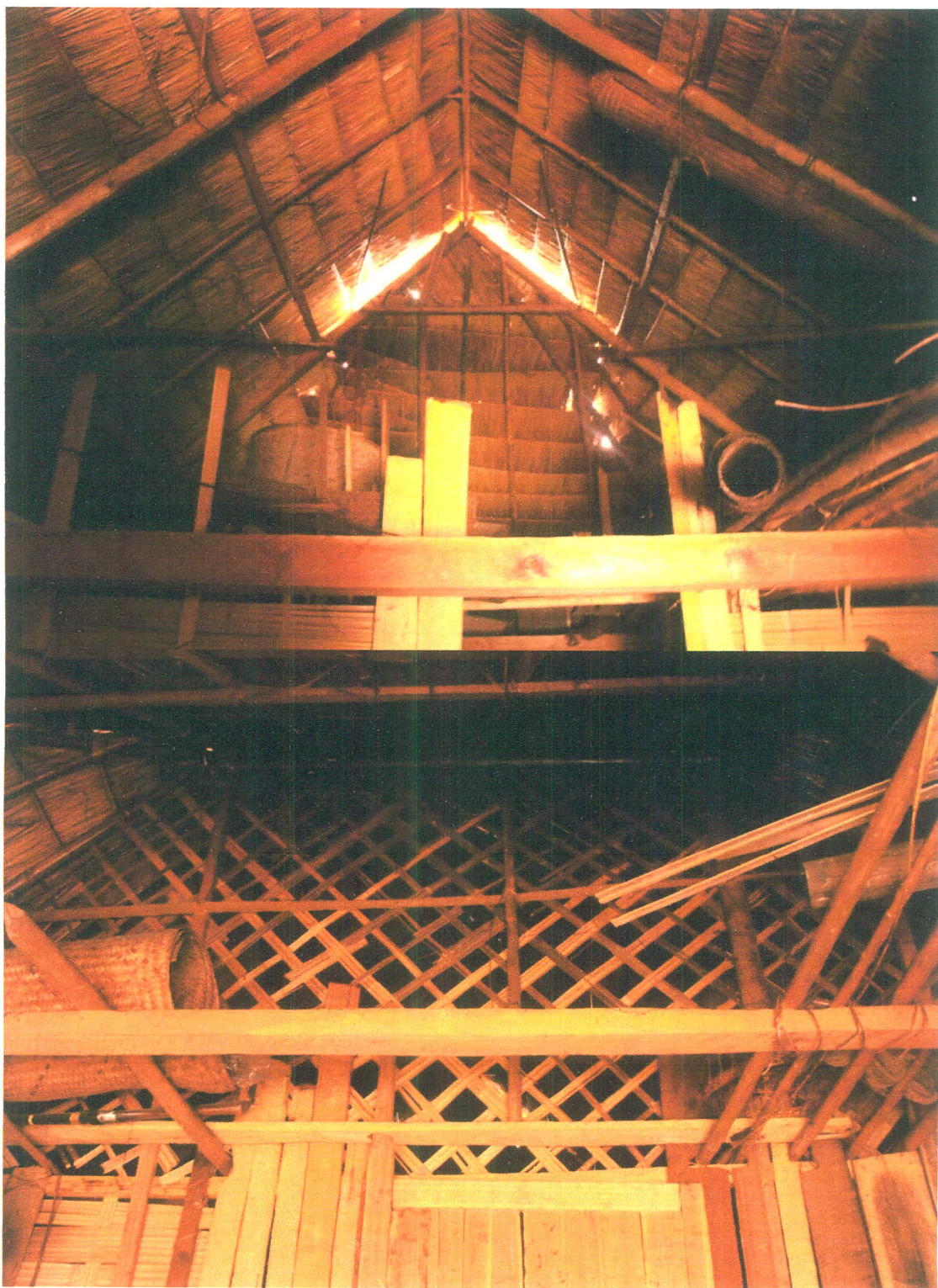
ภาพที่ 4.28 แสดงช่องเปิดระบายลมเหนือประตูภายในเรือนปรัย ที่มา : จากการสำรวจภาคสนาม โดย สัณชัย สุพิพัฒน์มงคล
