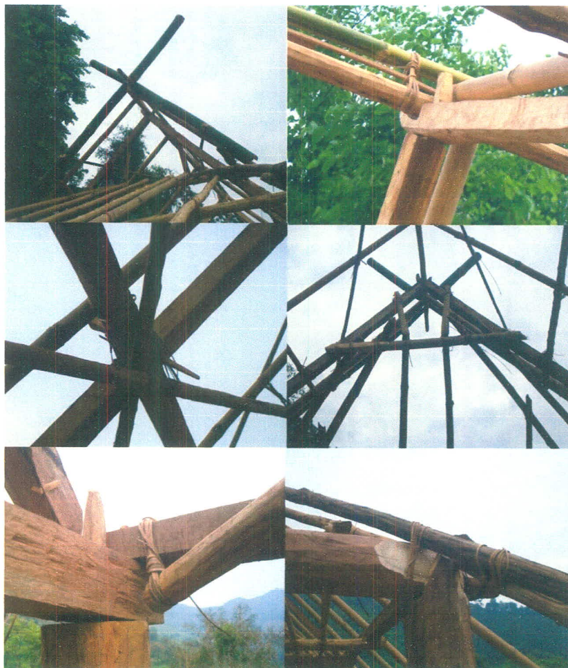
ภาพที่ 4.33 แสดงรายละเอียดโครงสร้างหลังคาเรือนพักอาศัยชาวปรี บ้านปากำ ที่มา : จากการเก็บข้อมูลภาคสนามโดย สัญชัย สุพิพัฒน์มงคล
