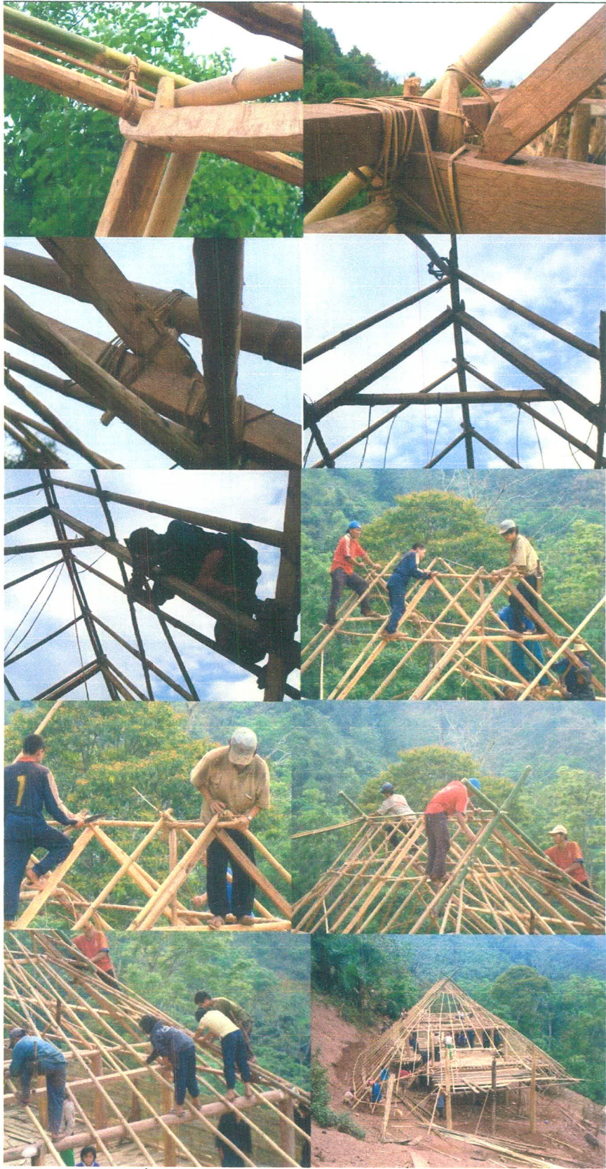
ภาพที่ 3.33 แสดงรายละเอียดการทำโครงหลังคาเรือน ที่มา : จากการสำรวจภาคสนามโดย สัณชัย สุพิพัฒน์มงคล
