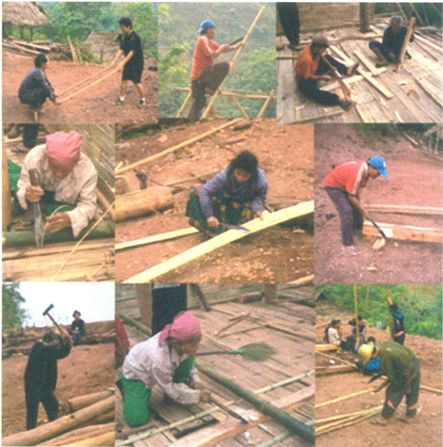
ภาพที่ 3.25 แสดงลักษณะการใช้เครื่องมือในการสร้างเรือนบ้านปากำ ที่มา : จากการสำรวจภาคสนามโดย สัณชัย สุพิพัฒน์มงคล
