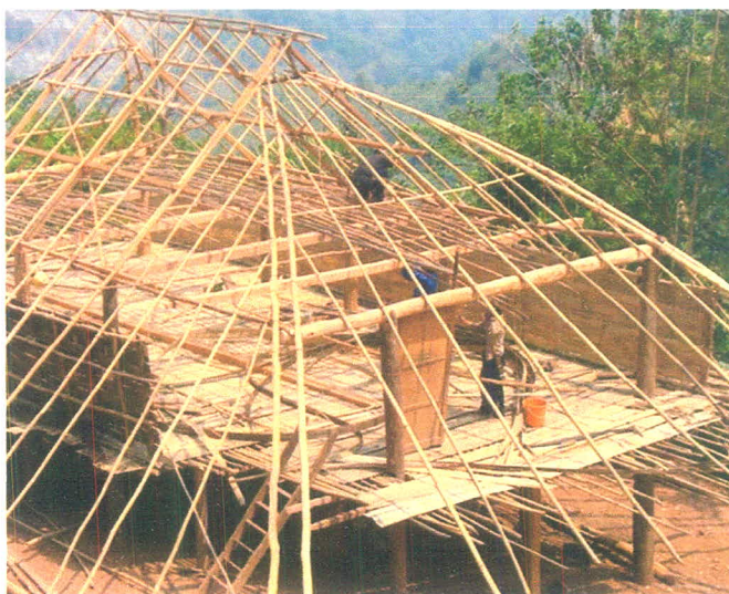
ภาพที่ 3.96 แสดงลักษณะโครงสร้างช่วงบนของเรือน
