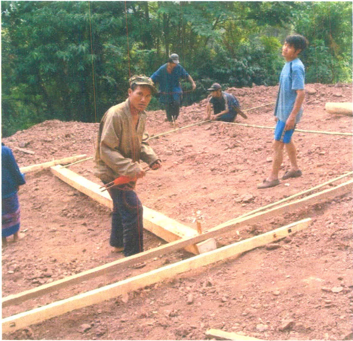
ภาพที่ 3.27 แสดงการใช้เชือกวัดขนาดขณะสร้างเรือนใหม่ ที่มา : จากการสำรวจภาคสนามโดย สัณชัย สุพิพัฒน์มงคล
