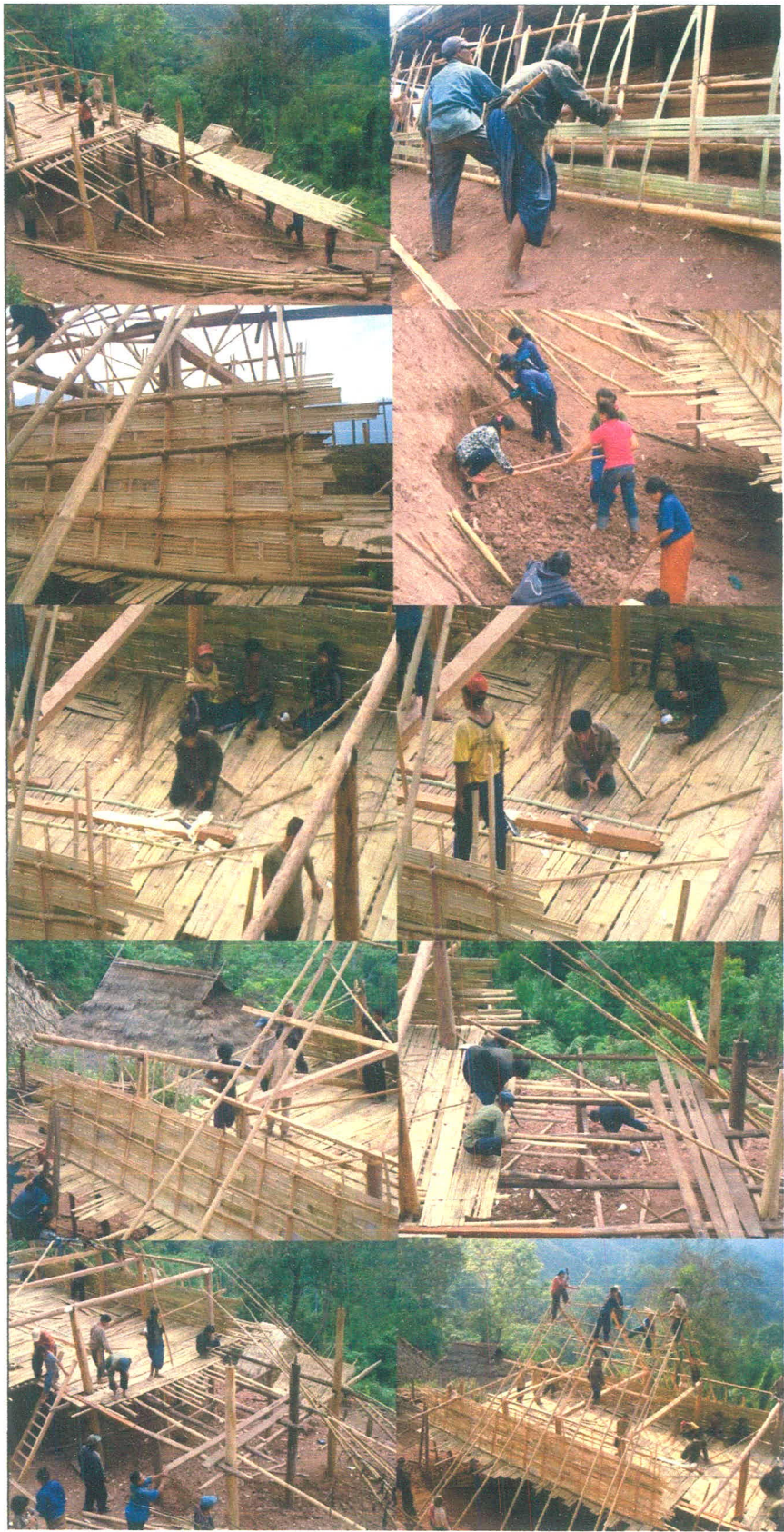
ภาพที่ 3.32 แสดงขั้นตอนการปูพื้นและกันผนังภายนอก ที่มา : จากการสำรวจภาคสนามโดย สัณชัย สุพิพัฒน์มงคล
