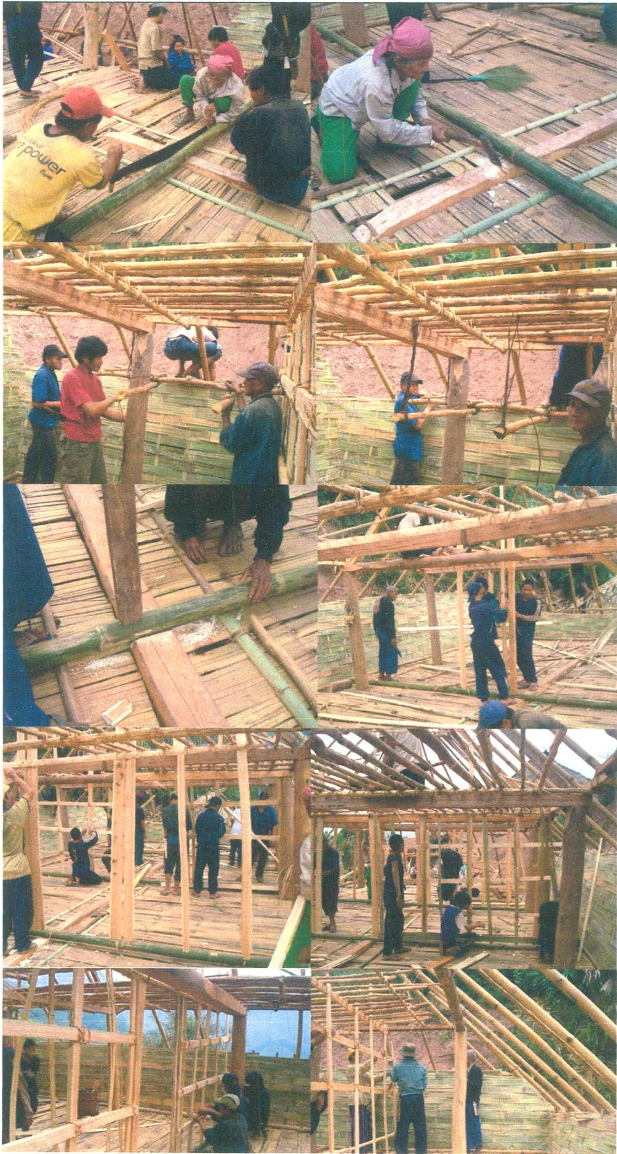
ภาพที่ 3.34 แสดงขั้นตอนการกั้นผนังภายในเรือน ที่มา : จากการสำรวจภาคสนามโดย สัณชัย สุพิพัฒน์มงคล
