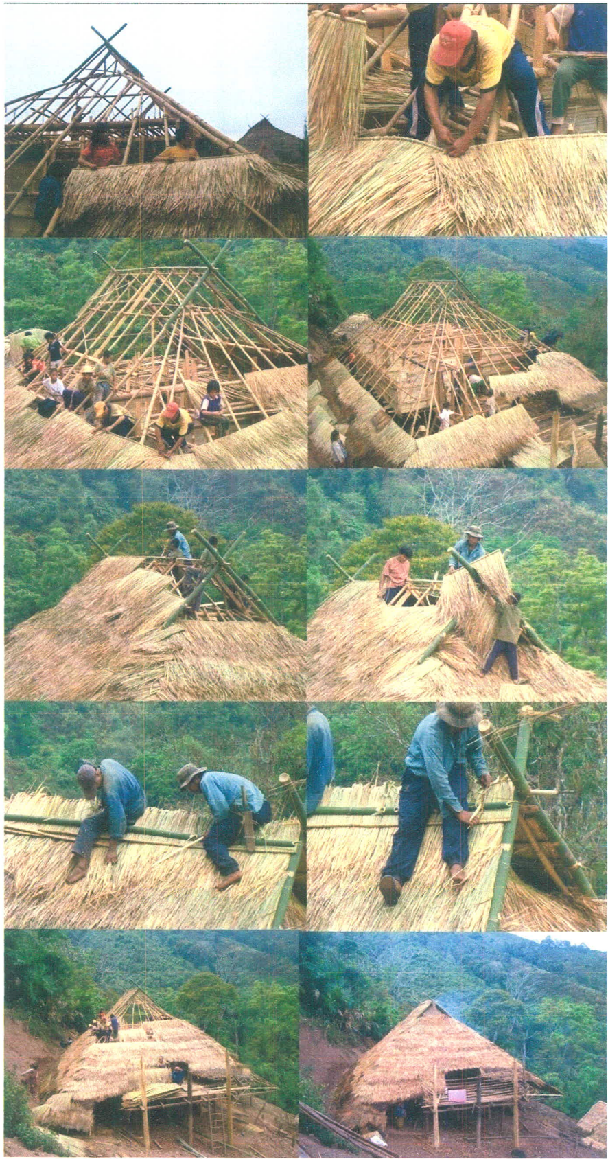
ภาพที่ 3.35 แสดงขั้นตอนการมุงหลังคาเรือน ที่มา : จากการสำรวจภาคสนามโดย สัณชัย สุพิพัฒน์มงคล
