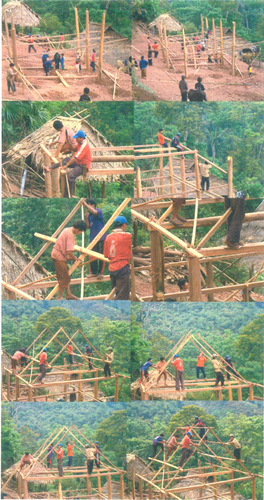
ภาพที่ 3.31 แสดงขั้นตอนการตั้งเสาและขึ้นโครงหลังคา ที่มา : จากการสำรวจภาคสนามโดย สัณชัย สุพิพัฒน์มงคล
