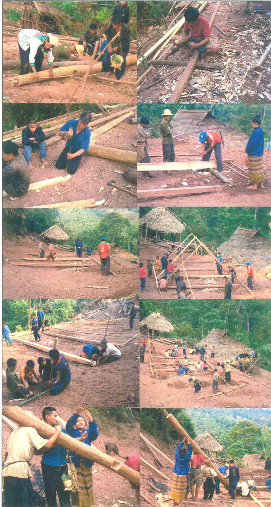
ภาพที่ 3.30 แสดงขั้นตอนการเตรียมเสาเรือน ขุดหลุมและฝังเสาแยก ที่มา : จากการสำรวจภาคสนามโดย สัณชัย สุพิพัฒน์มงคล
