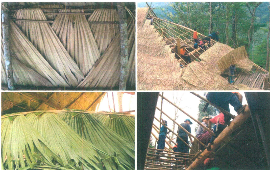
ภาพที่ 3.103 แสดงการใช้ใบค้อและหญ้าค่าในการมุงหลังคา ที่มา : จากการสำรวจภาคสนามโดย สัณชัย สุพิพัฒน์มงคล
