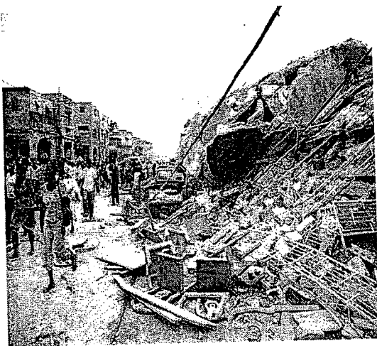
รูปที่ 1.1 ความเสียหายของโครงสร้างคอนกรีตเสริมเหล็กจากแรงแผ่นดินไหว
