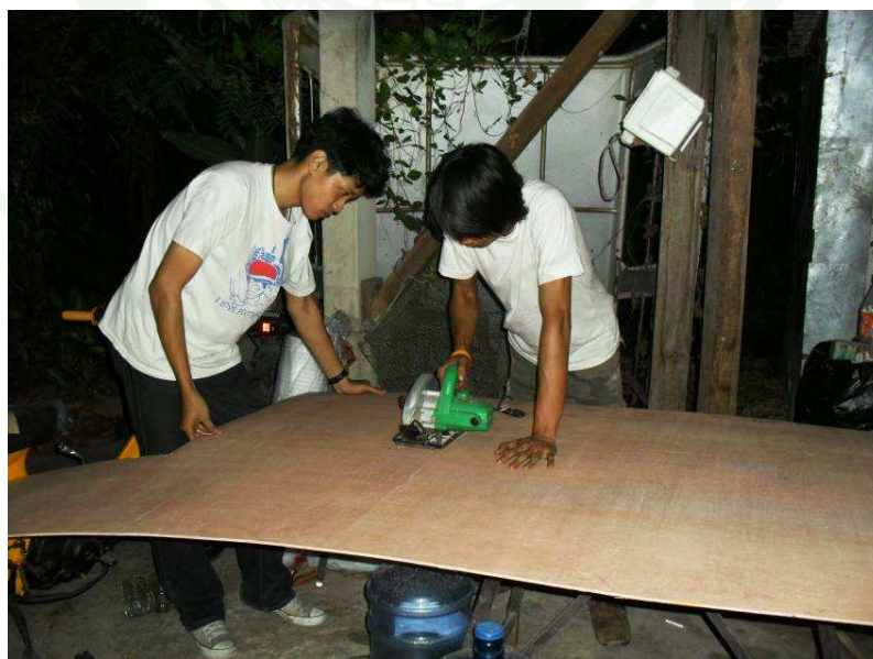
ภาพผนวกที่ 52 ตัดไม้อัดตามขนาดที่วัดไว้สำหรับทำเป็นแผ่นยึดหุ่นจำลอง
