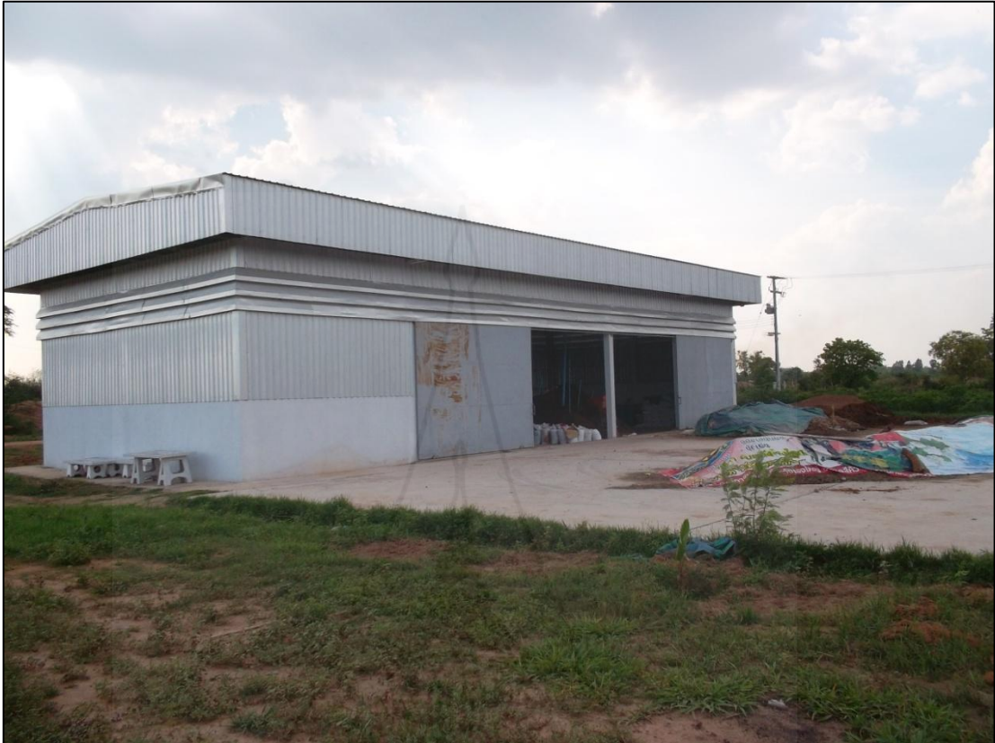
ภาพถ่ายโรงงานผลิตปุ๋ยอินทรีย์
