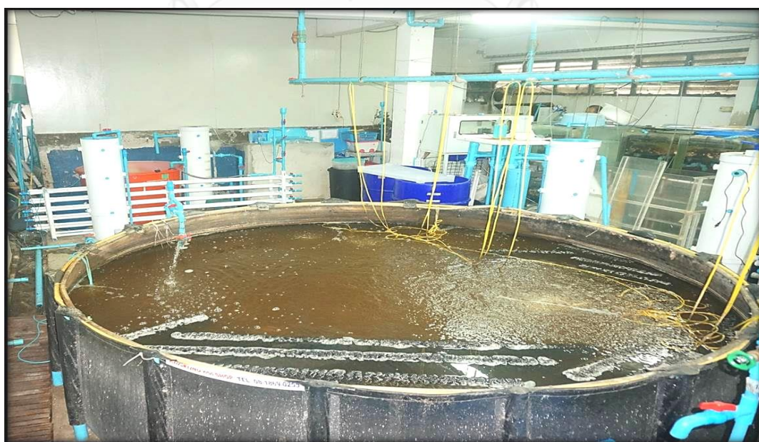
ภาพที่ 3.17 ภาพถ่ายมุมกว้างแสดงการติดตั้งระบบตีโนทรีฟเคชั่นเข้ากับระบบเพาะเลี้ยงสัตว์น้ำ
