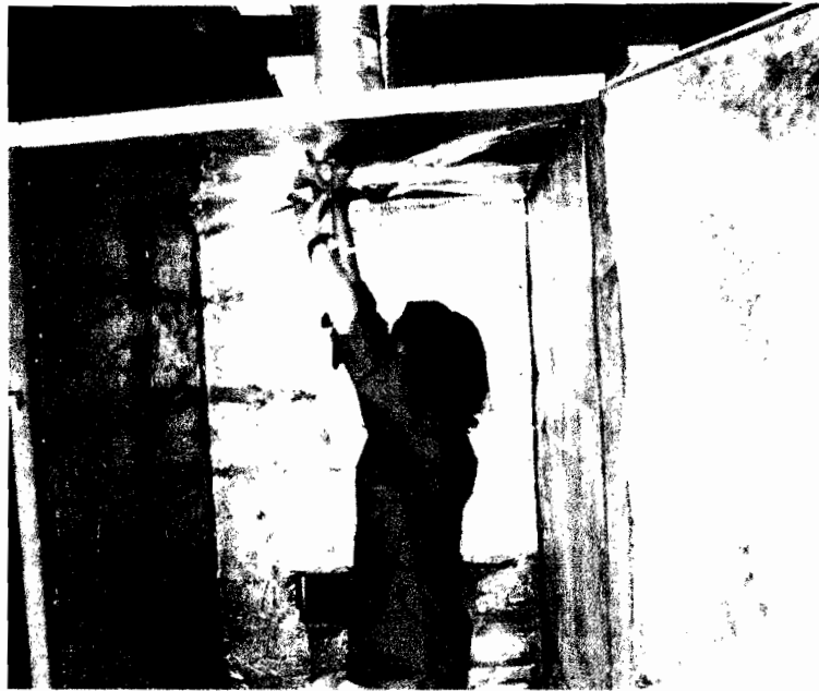
รูปที่3.5 แสดงการห้มฉนวนของคู้บปุ๋ยอินทรีย์
