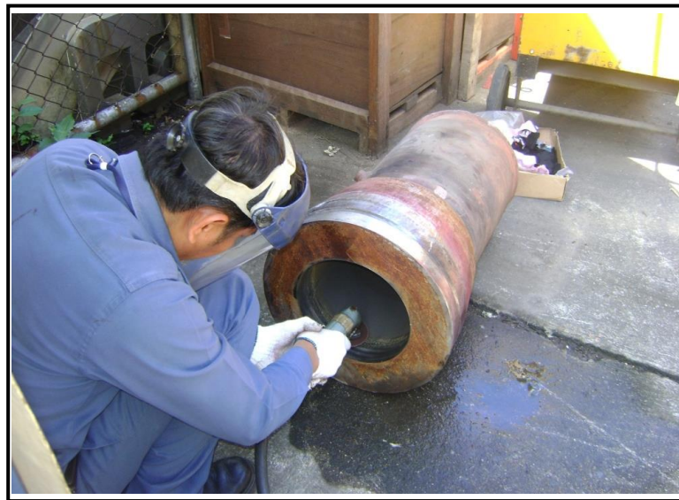
รูปที่ 3.12 ทำการ Clean เพื่อทำการตรวจสอบด้วยน้ำยา Penetrant test
