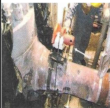
การตัดท่อด้วยเครื่อง Cut off Wheel
