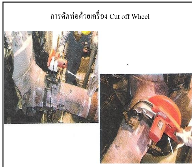
รูปที่ 3.9 ทำการตัดท่อ Expander ด้วย Cut Off Wheel ตัดขาดขั้นตอนสุดท้าย
