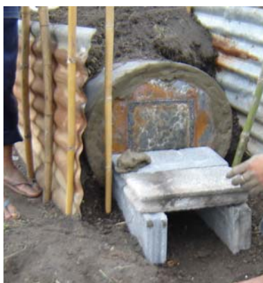
รูปที่ 3.15 การประกอบช่องใส่ไฟหน้าเตา
