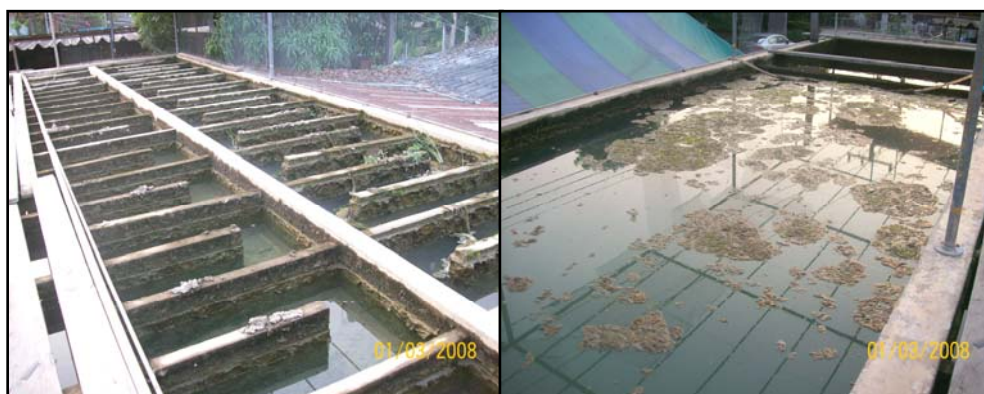
รูปที่ 2.2 แสดงถังตกตะกอนที่ใช้ในการผลิตน้ำประปาภายในมหาวิทยาลัยราชภัฏนครสวรรค์
