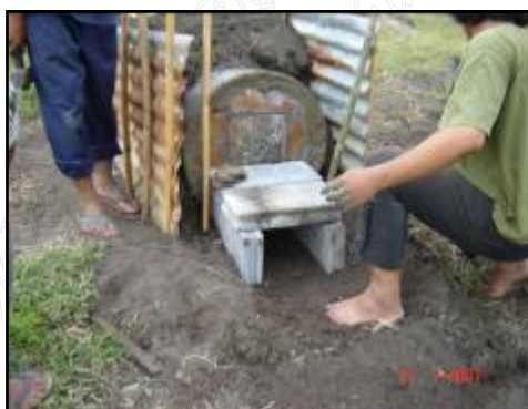
รูปที่ 3.4 แสดงการทำช่องหน้าเตาเพื่อใช้ในการก่อไฟบริเวณช่องหน้าเตา
