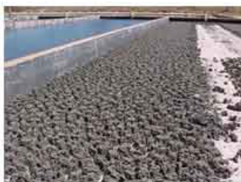
ภาพที่ 2.4 แสดงลานตากตะกอนฐานทราย (Sand Drying Bed)
