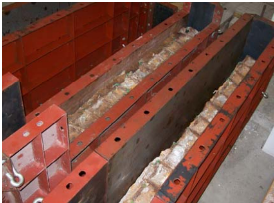
รูปที่ 4.7 การซ่อมแซมคาน ค.ส.ล. ที่เสียหายในชั้นฐานแรง
