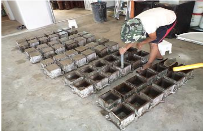
รูปที่ ค.5 การประกอบแบบหล่อคอนกรีต
