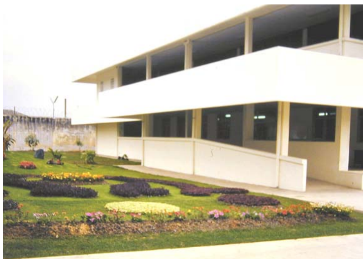
อาคารผู้ป่วยหญิงสร้างเมื่อปี พ.ศ. 2541
