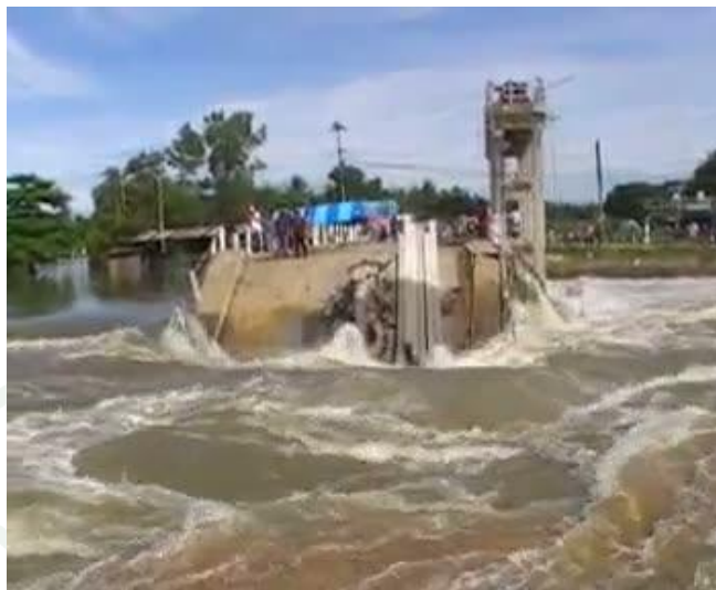
ภาพที่ 4.3 ประตูระบายน้ำบางโจมศรี อำเภออินทร์บุรี จังหวัดสิงห์บุรี
